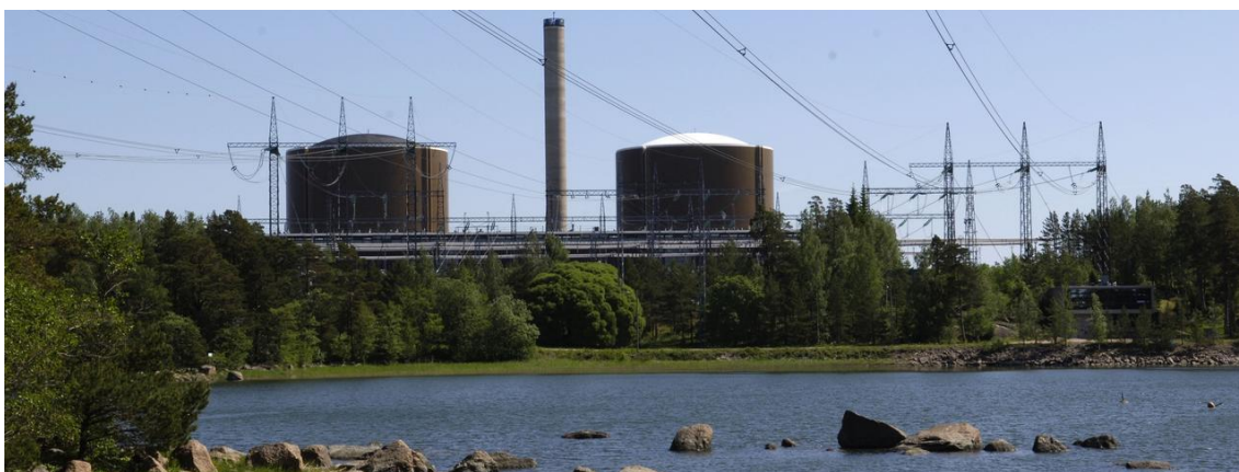
KUVA 1. Loviisan voimalaitos. (Fortum 2020b)
