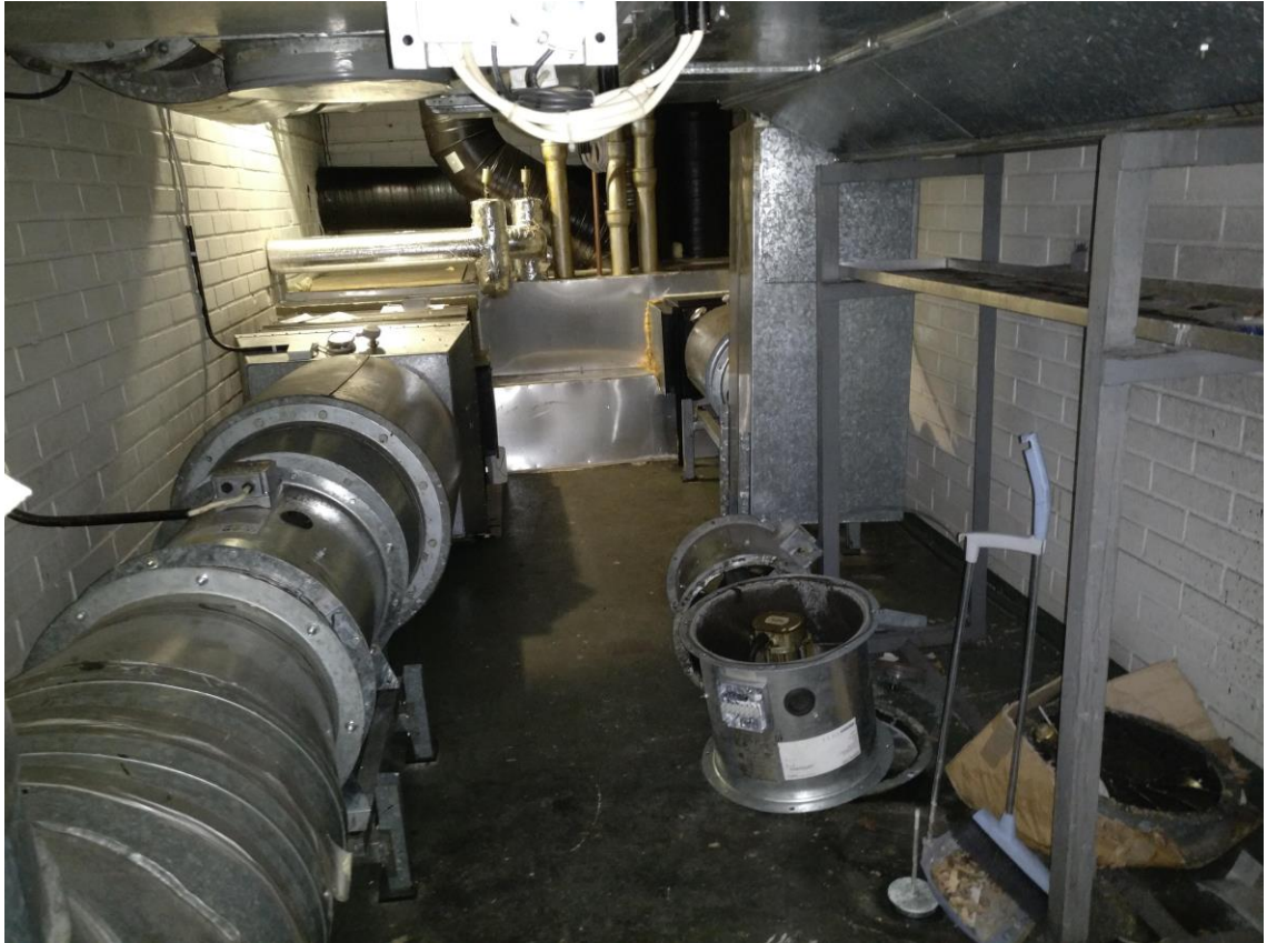
Kuva 3. Vesikatolla sijaitseva poistoilmakoneiden konehuone ennen saneerausta.
