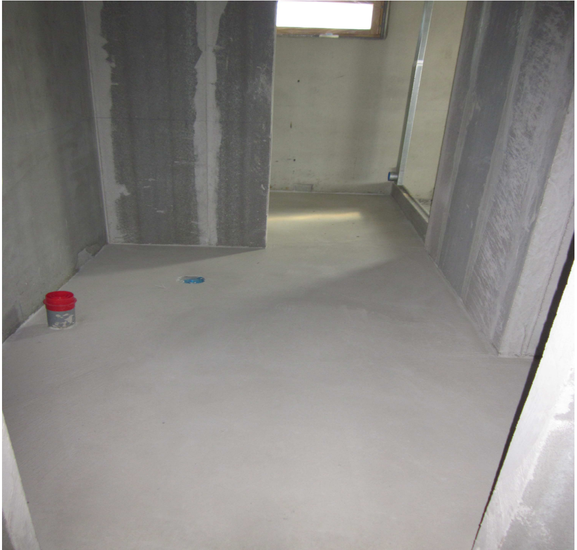
Kuvio 12. As Oy Espoon Aurinkopurjeen valettu kylpyhuonevaraus seinineen.
