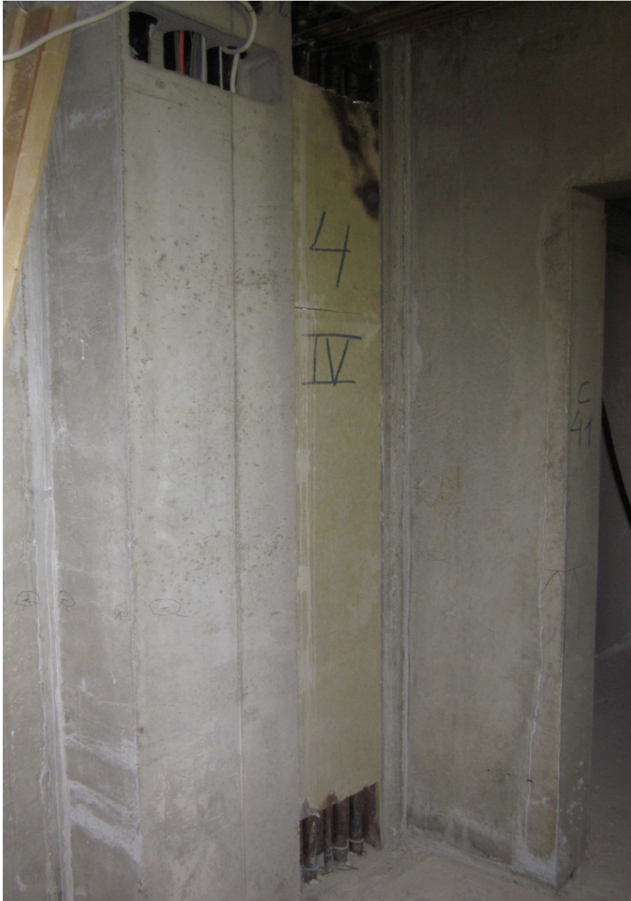
Kuvio 2. Elpo-hormin pieni levytettävä osuus, johon tulee myös vuodonilmaisimet.
