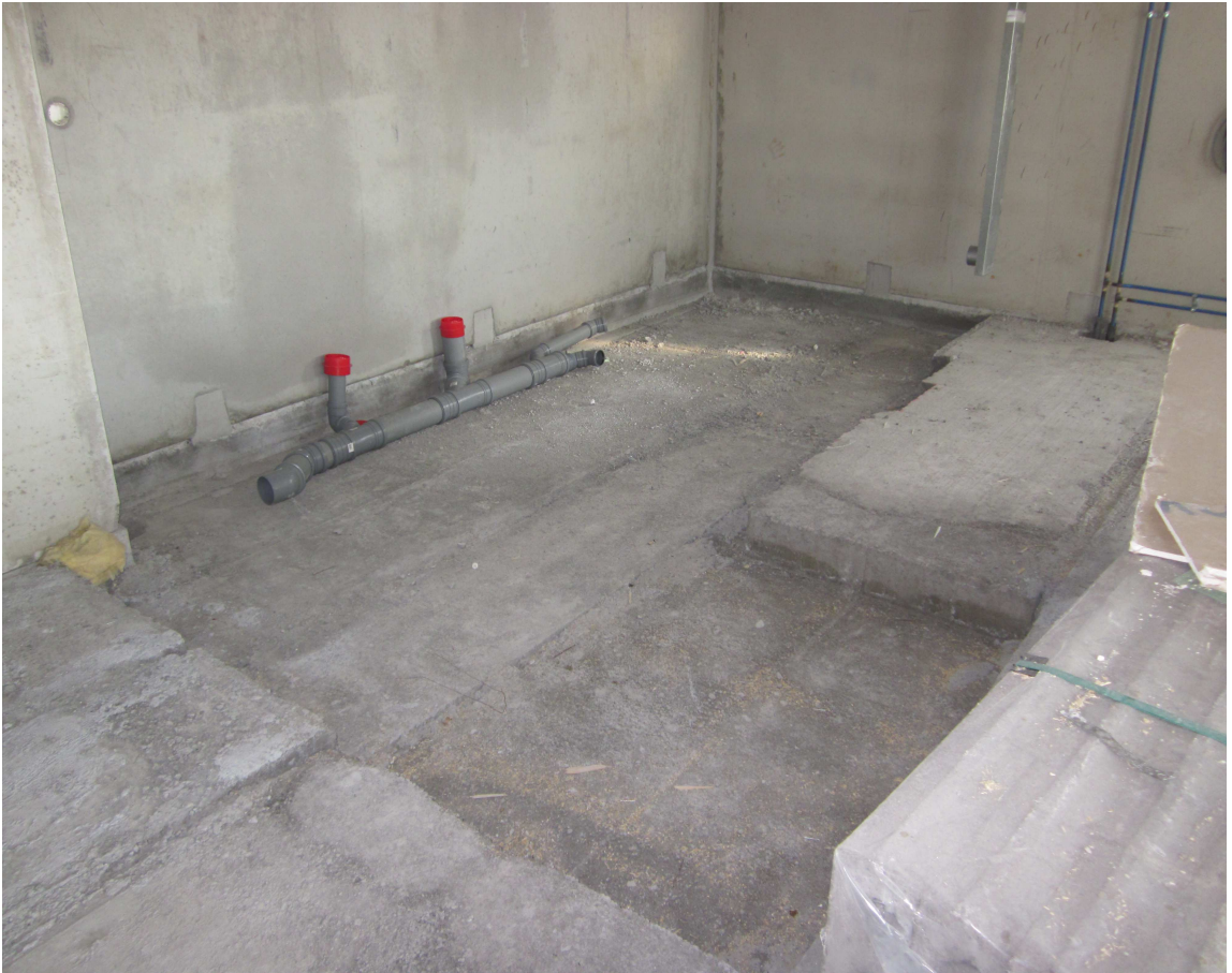
Kuvio 11. As Oy Espoon Aurinkopurjeen ontelolaattojen kylpyhuonevaraus. Aco-seinät eivät ole vielä paikallaan.
