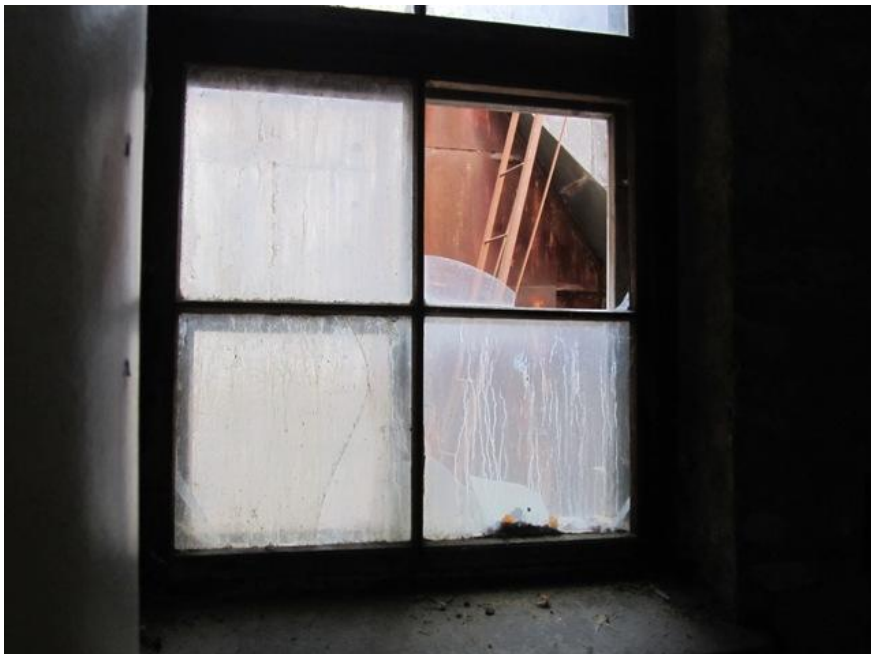
Kuva 12. Kemikaaliaseman alakerran ikkuna
