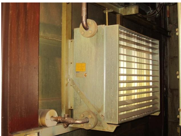
Kuva 7. Höyrylämmitteinen lämminilmakoje lauhteenpoistimella
