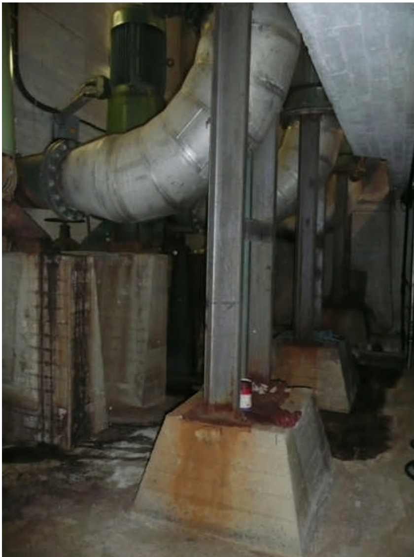
KUVA 2. Kuva pumppaamosta ennen saneerausta.
