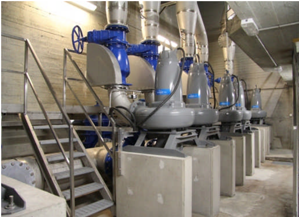
KUVA 9. Kuva pumppaamosta saneerauksen valmistuttua.
