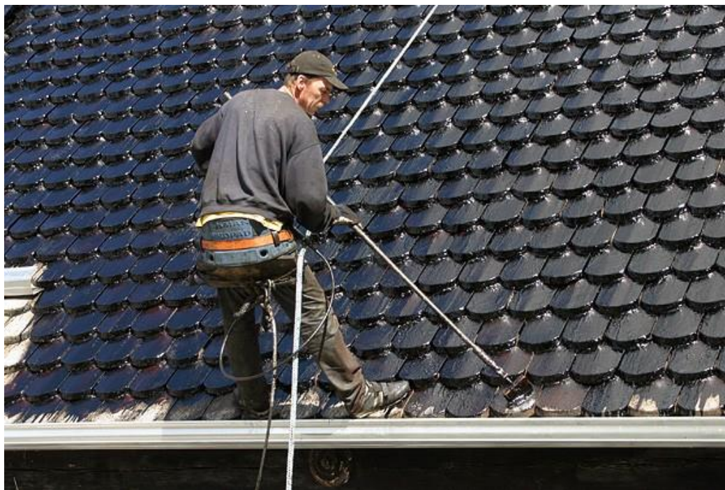
Kuva 16. Paanukattoa tervataan. (Laamanen, [viitattu 25.10.2011].)
