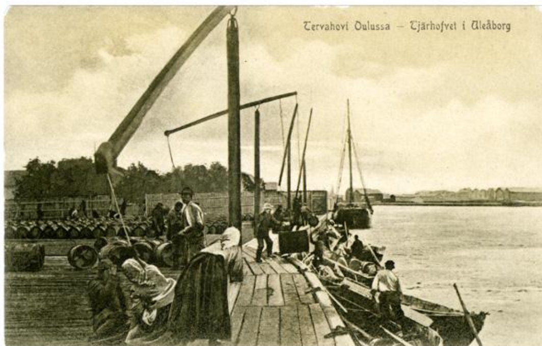
Kuva 2. Tervatynnyreitä nostetaan vinsseillä tervahovin laiturille. (Keskitalo 2011.)
