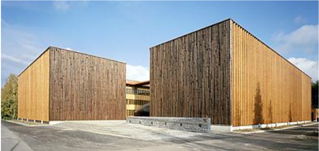
Kuva 17. Roslagin mahongilla voidaan käsitellä myös moderneja rakennuksia, kuvassa Joensuun Metsäntutkimuslaitos. (Tiainen 2011.)
