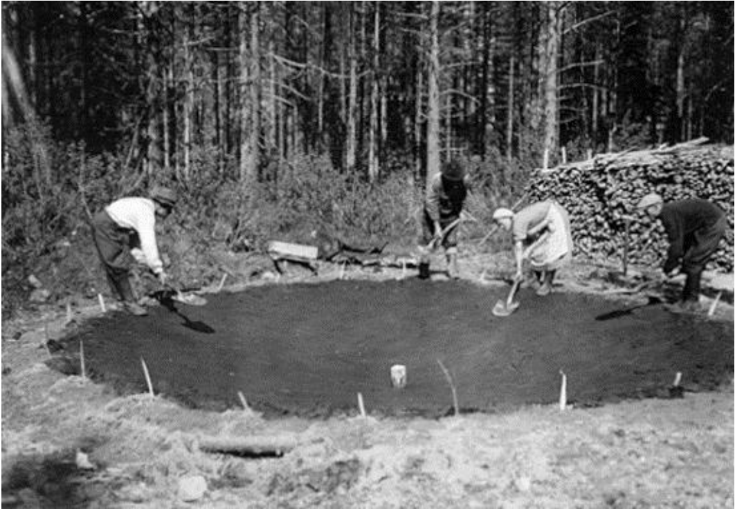
Kuva 11. Tervahaudan pohjaa tiivistetään savella. (Keskitalo 2011.)
