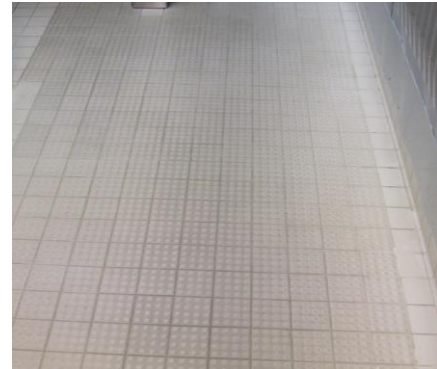
KUVA 5. Kulkureitti aulasta miesten pukuhuoneeseen (Kuva Pauliina Talli 2011).
