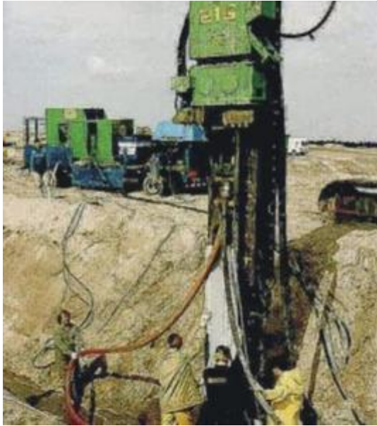
Kuva 14. Korkeapaine vesisuihkutus. (Geosintetika.2011)
