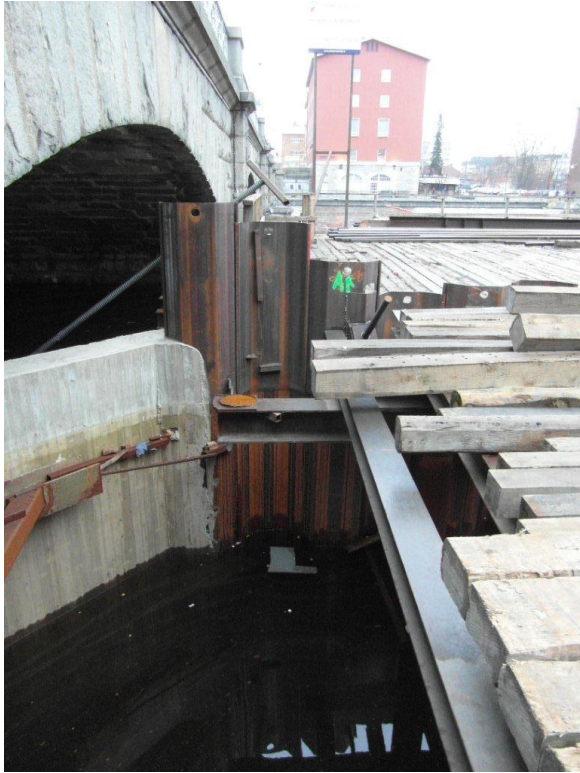
Kuva 20. Frenckellin patotyömaa. Ponttiseinän alku.
