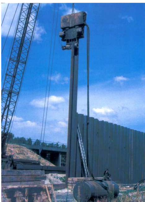
Kuva 6. Roikotettava vibra (Installation of Steel Sheet Piling 1998,24)
