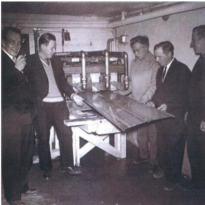
Kuva 2. Ensimmäisten kattojen profilointia vuonna 1961. (Junnila 1996,10.)
