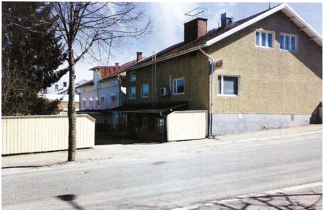
Kuva 2.1 Edustalla leipomorakennus ja taustalla asuinrakennus.
