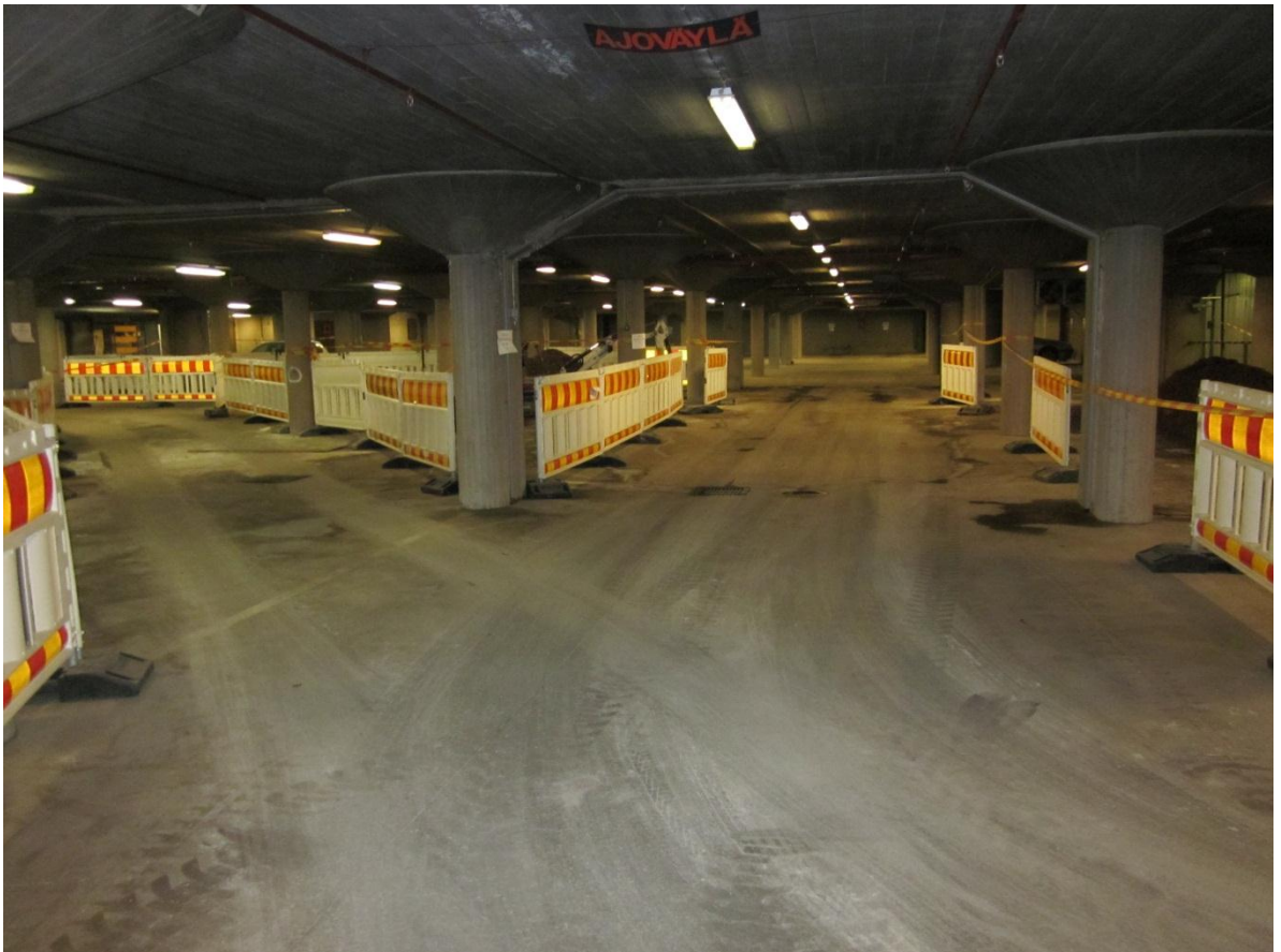
KUVIO 4. Kellarissa tehtiin liikennejärjestelyjä kiinteistön käyttäjiä varten.
