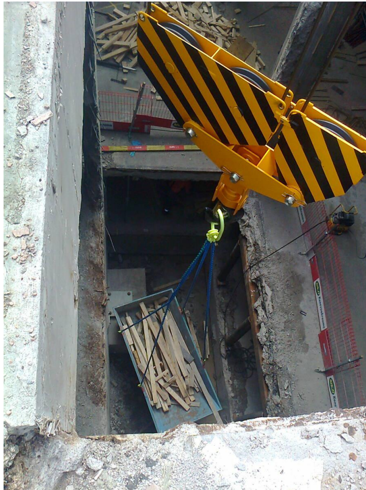
KUVIO 6. Rakennusjätettä poistettiin kellarista vanhan hissikuilun kautta roskajassikalla.
