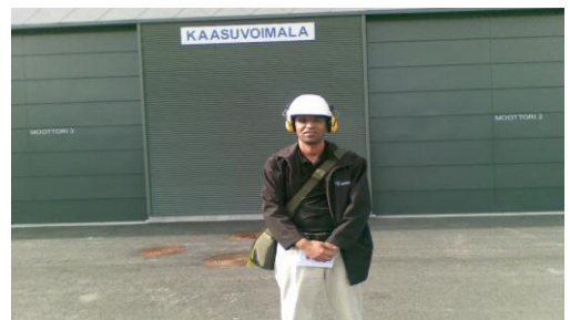
Power plant at Ammässuo, Espoo
