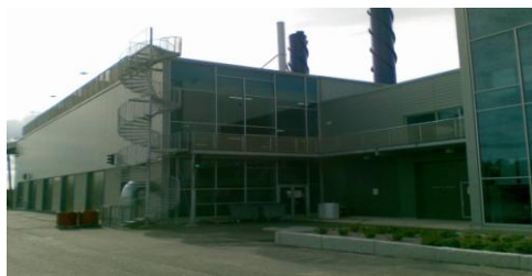
Ammässuo Landfill Power plant
