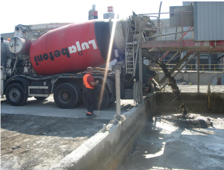
Kuva 33. Betoniautoni pesupaikalla. Valokuva Mikael Gull 2011
