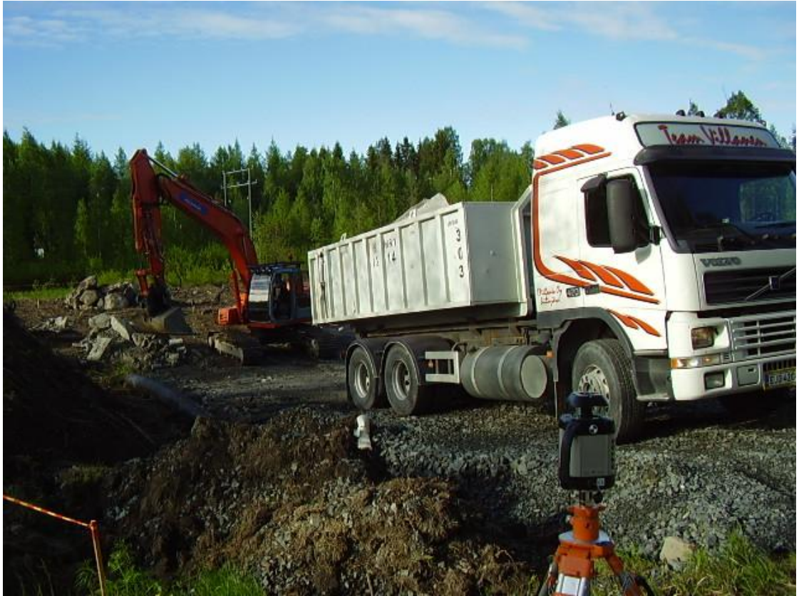
Kuva 25. Ensimmäiset betonijätetuormat työmaalle. Kuvassa etualalla on tasolaseri, jolla mitattiin pohjamaan korko. Valokuva Mikael Gull 2011
