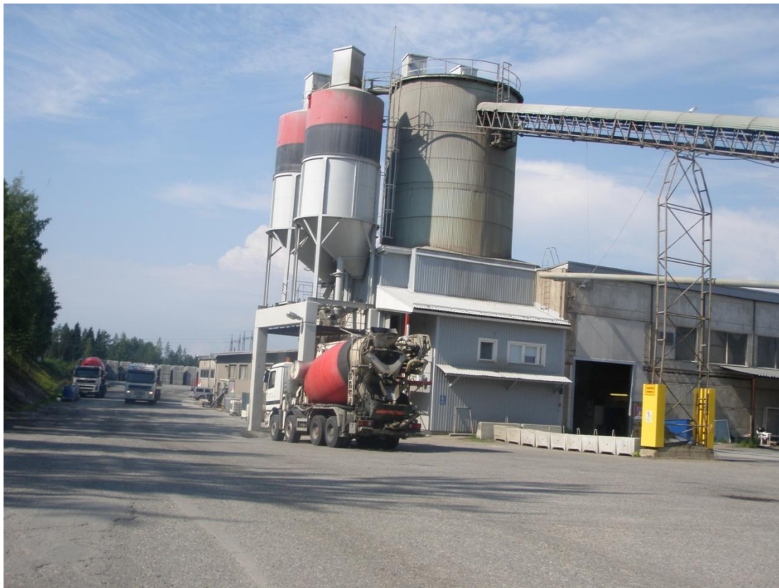
Kuva 26. Valmisbetonin valmistuspaikka. Kuvassa betoniauto on valmisbetonin otto- paikalla. Valokuva Mikael Gull 2011
