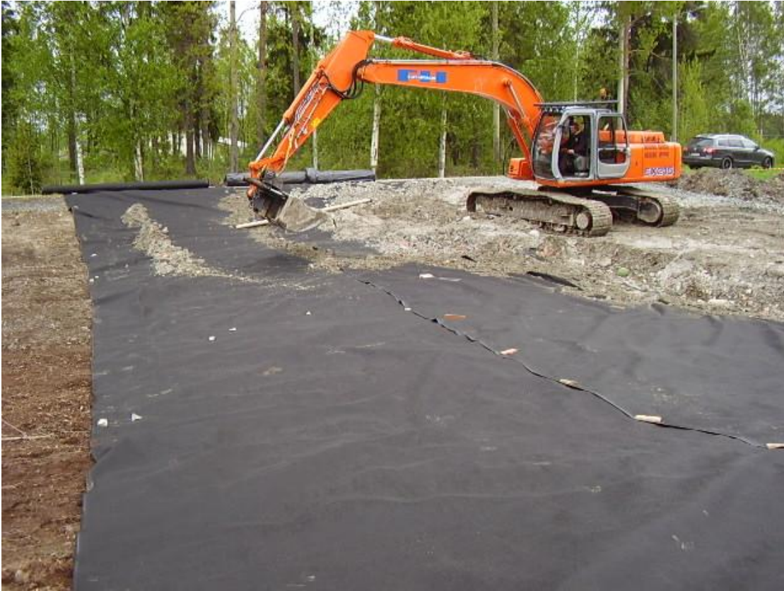
Kuva 24. Suodatinkangas on levitetty pohjamaan päällä. Valokuva Mikael Gull 2011
