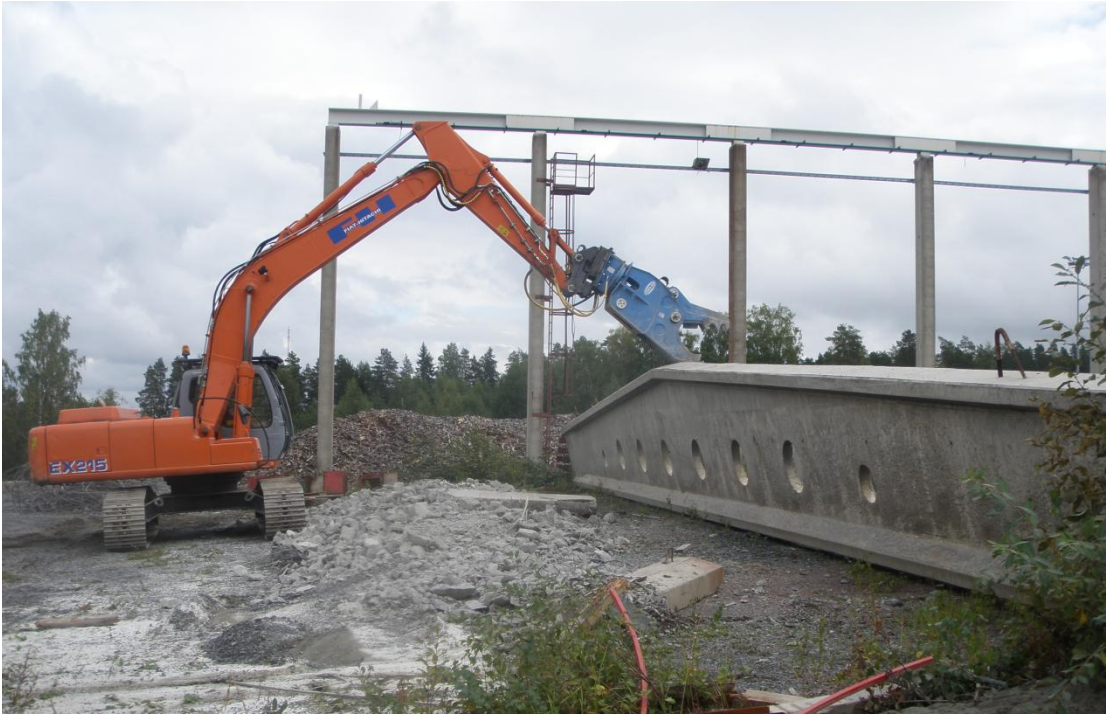
Kuva 32. Suurien harjapalkkien pulverointia tehtaan pihamaalla. Toinen palkki on pulveroituna kaivinkoneen edustalla. Valokuva Mikael Gull 2011
