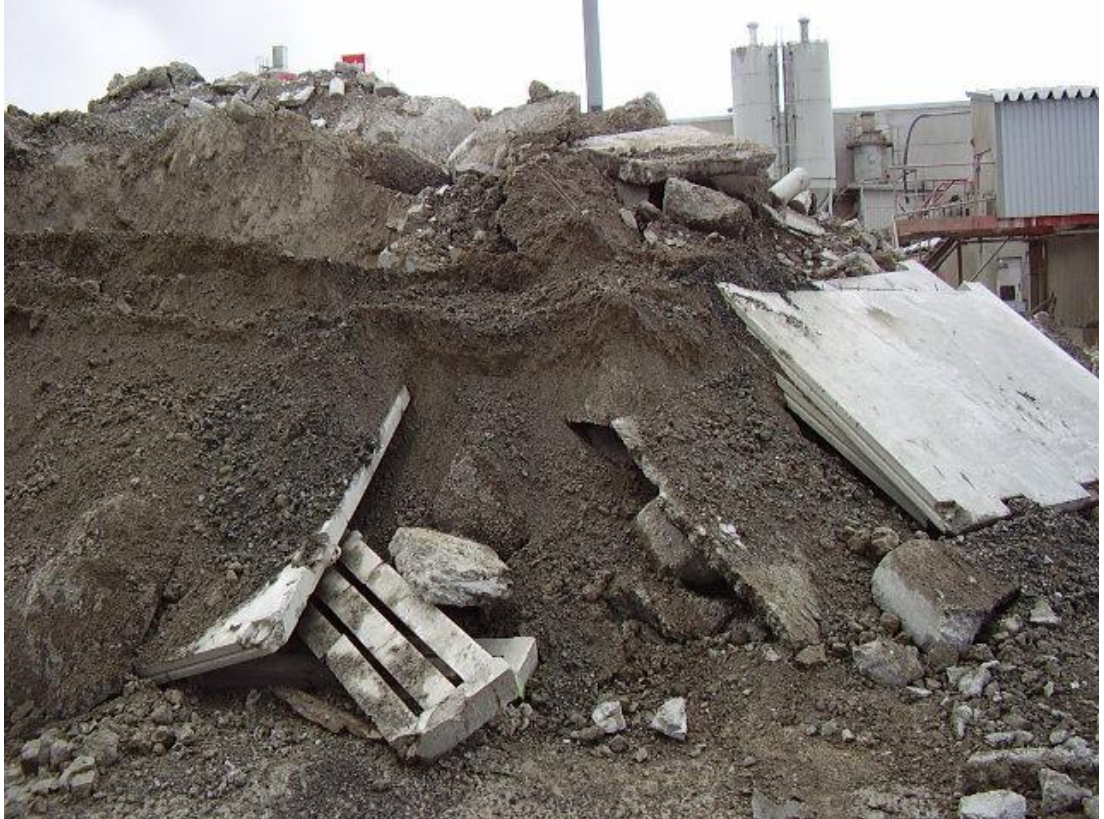
Kuva 31. Betonitehtaan jätebetonin varastokasa. Valokuva Mikael Gull 2011
