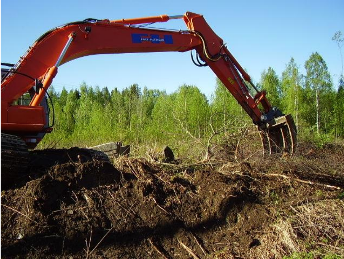
Kuva 22. Risujen ja kantojen poistoa kantoharalla. Valokuva Mikael Gull 2011
