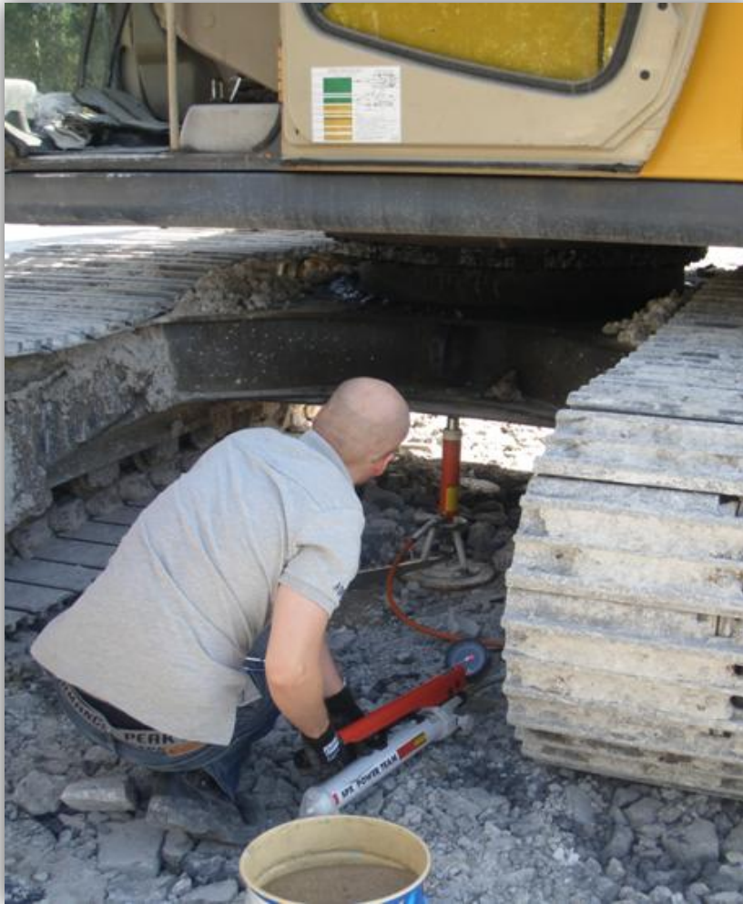
Kuva 4. Levykuormituskokeen suorittaminen. Vastapainona kaivinkone. Valokuva Mikael Gull 2011
