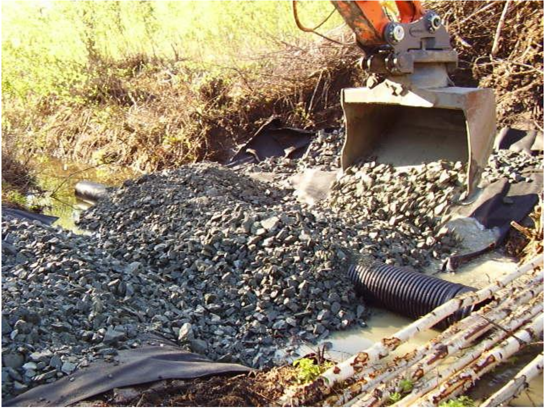
Kuva 21. Työmaatin tekoa ja väliaikaisen rumpuputken asentamista. Valokuva Mikael Gull 2011
