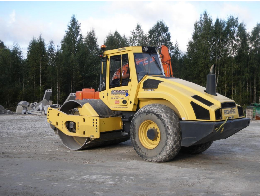
Kuva 45. Rakenteen tiivistystä jyrällä.
