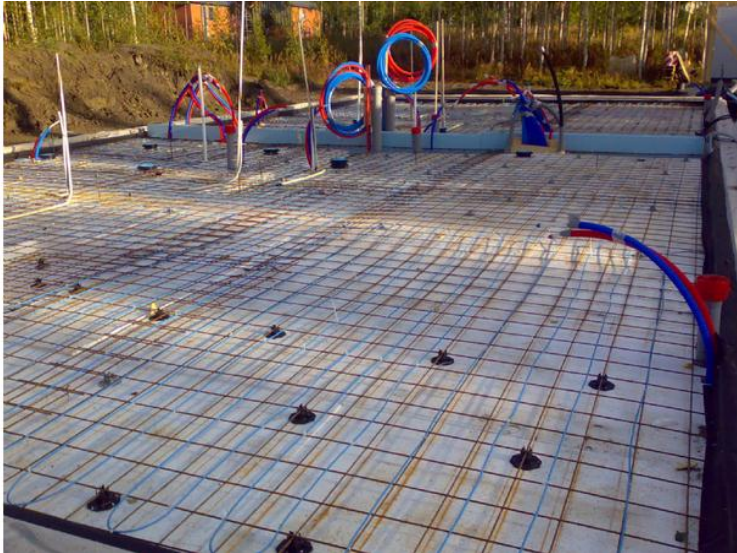
Kuva 2. Rakennuksen perustukset ja alapohja.
