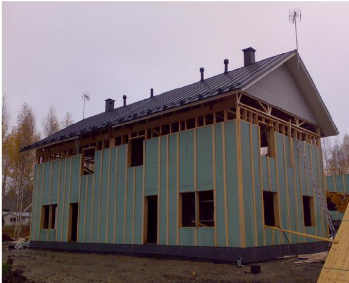
Kuva 1. Tutkittava kohde on 2-kerroksinen paritalo.
