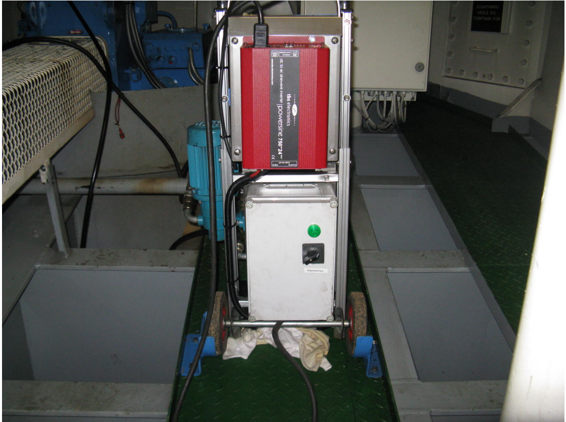
KUVA 7. Lossin potkurilaitteen invertteri käyttöinen öljynpuhdistaja
