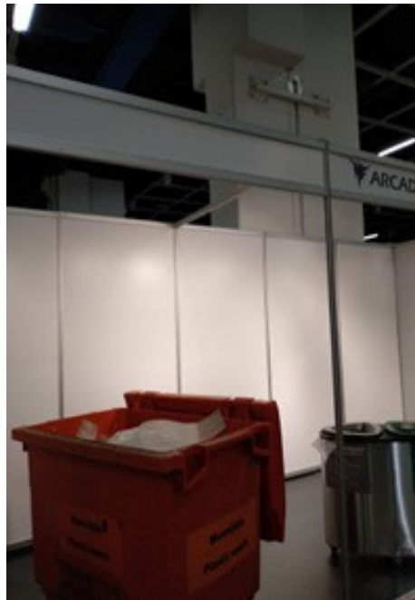
Kuva 1 Messuosaston rakentamista 10.3.2020 (Kuva: Mirja Andersson).
