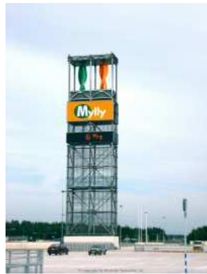
KUVIO 7. Kaksi Windside Oy:n WS12 –voimalaa kauppakeskuksen mainostornissa (Kuva: Windside Oy 2011)
