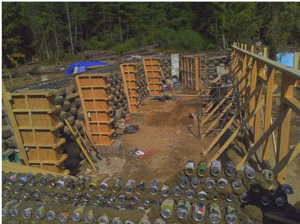
KUVIO 12. Kanadaan rakennetun Earthship -konseptin mukaisen ekotalon rakennusmateriaaleina käytettiin muun muassa hiekalla täytettyjä autonrenkaita, tyhjiä juomatölkkejä ja puuta (Earthship Bioteecture 2011)
