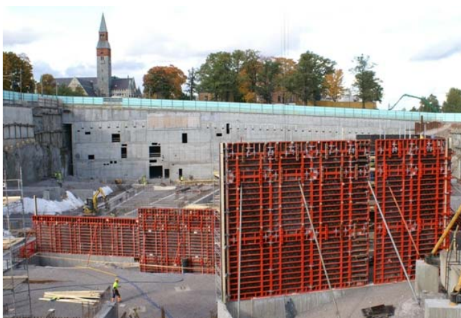
Kuva 1: TRIO-muotteja käytettiin Musiikkitalon rakentamiseen (PERI Suomi 2011.)
