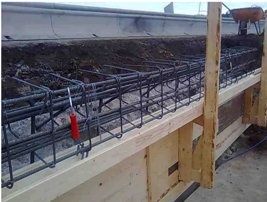
KUVA 6. Raudoituksen asentaminen ennen muottipintaa
