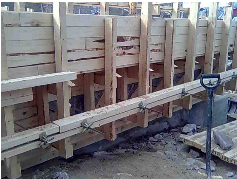
Kuva 11. Holvisillan reunapalkin ulkopuolen muotti.
