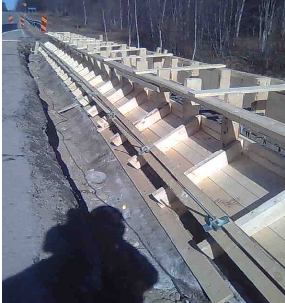
Kuva 13. Holvisillan sisäpuolen muotti.
