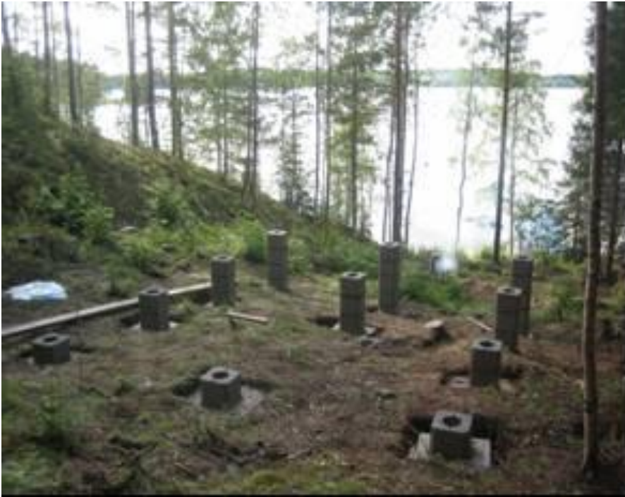
Kuva 16. Aitan pilariperustukset. Kuva: Toni Liikanen 2011
