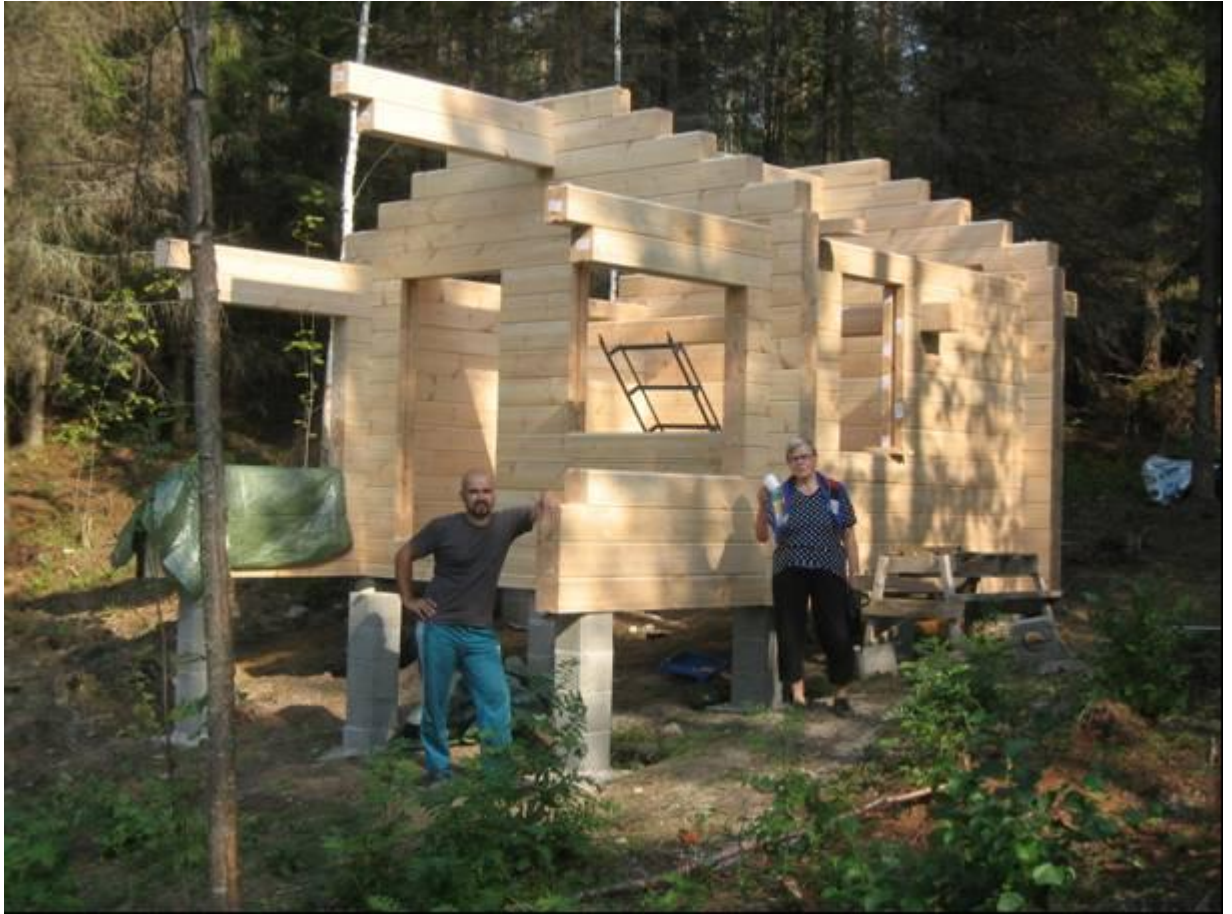
Kuva 18. Aitan lamellihirsikehikko valmis (hirren paksuus 165*198 mm).
