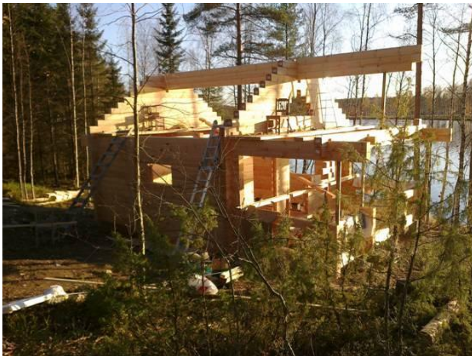
Kuva 15. Rantasaunan hirsikehikko. Kuva: Toni Liikanen 2011
