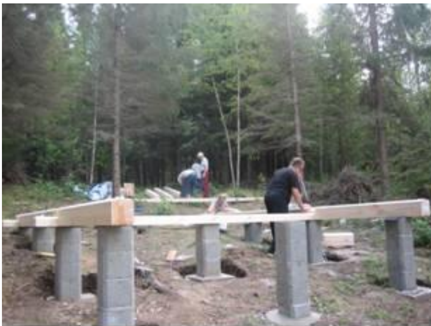
Kuva 17. Aitan 1. hirsikerros ristimitaan. Kuva: Toni Liikanen 2011
