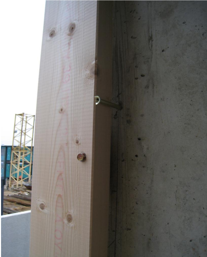
KUVA 7. Elementin kiinnitys betoniruuviankkurilla
