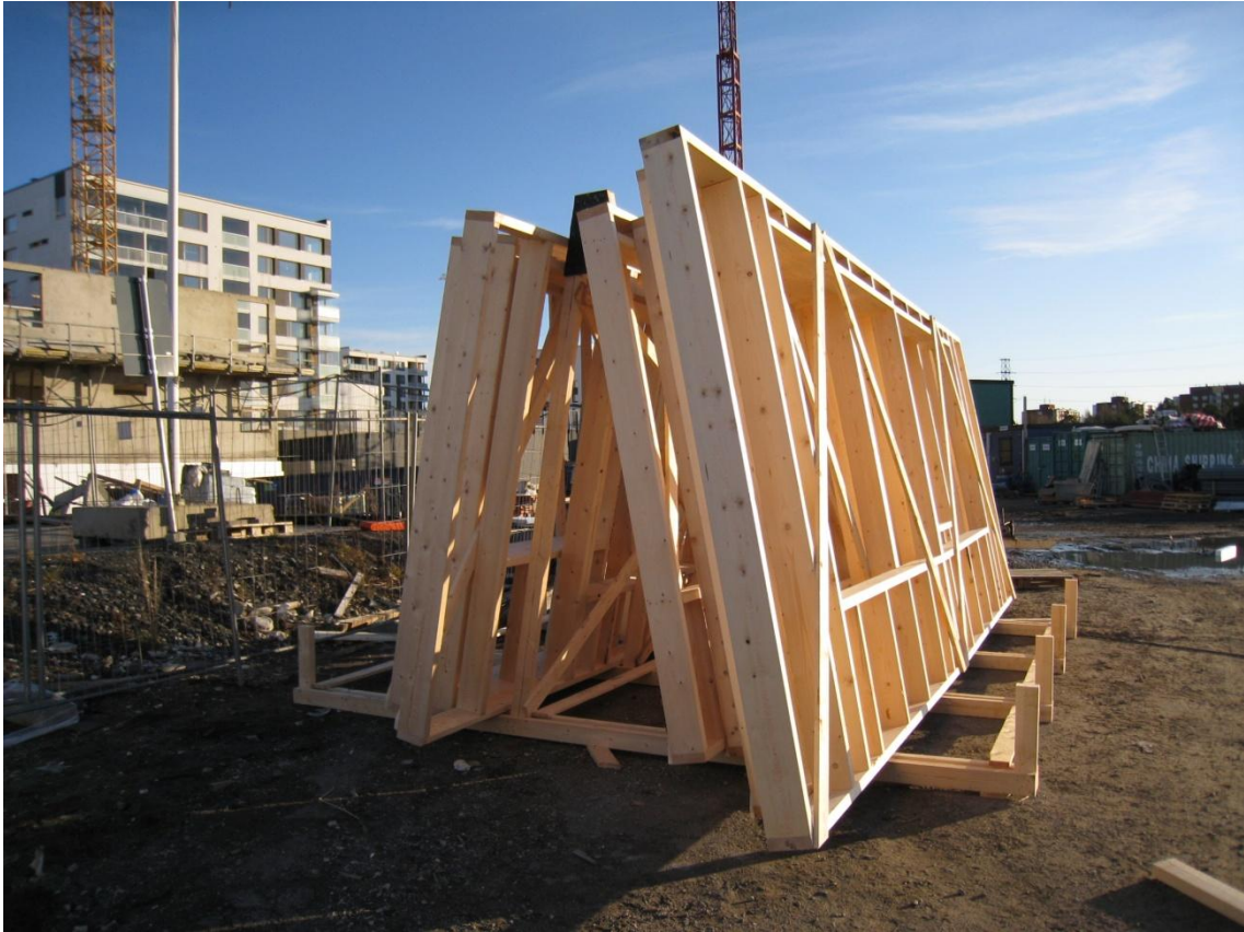
KUVA 6. Valmiit elementit varastoituna elementtivakkiin
