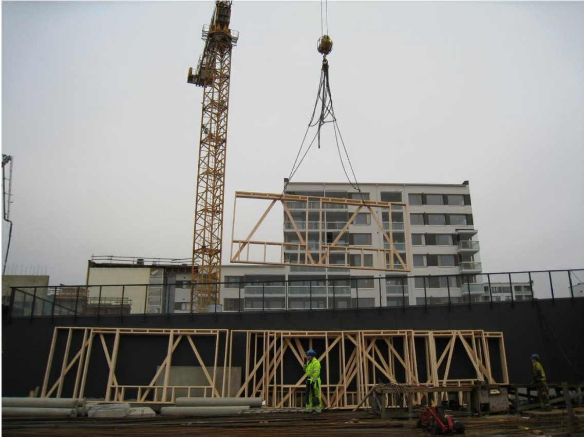
KUVA 5. Elementin nosto torninosturilla
