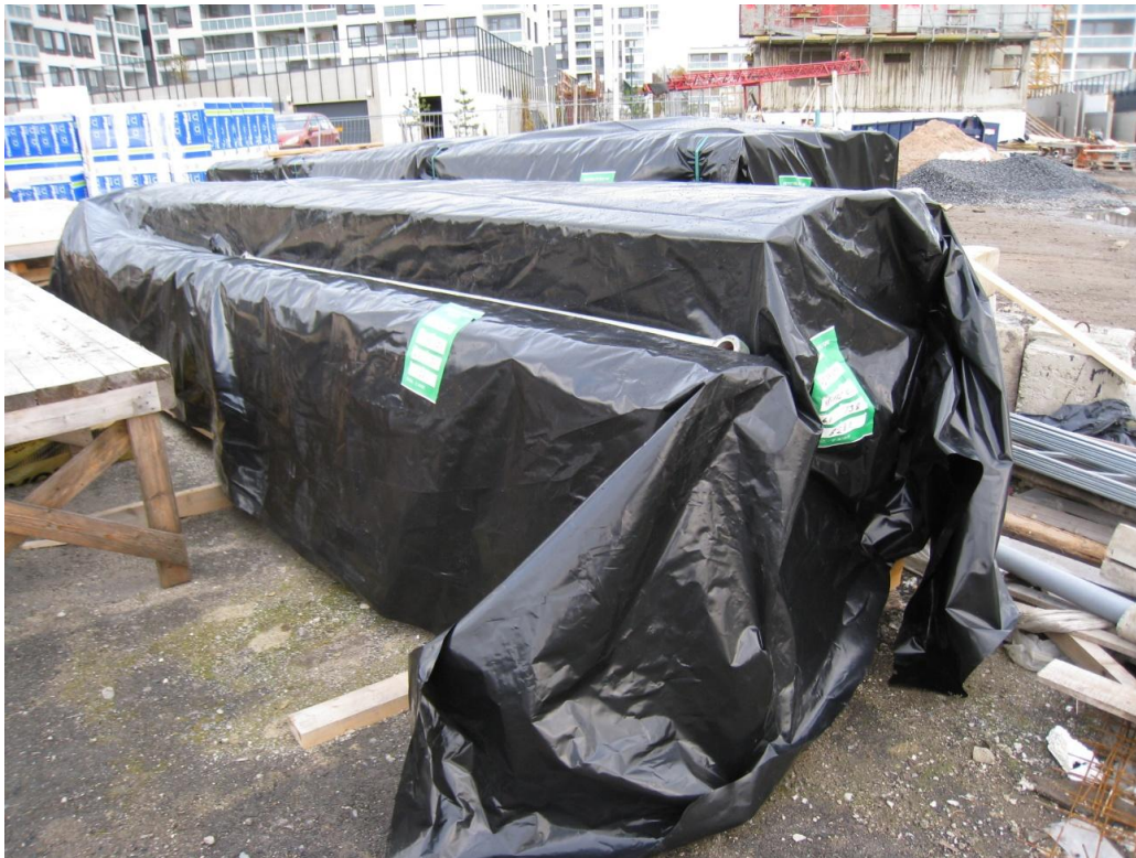
KUVA 8. Puutavara varastoidaan suojaan kosteudelta
