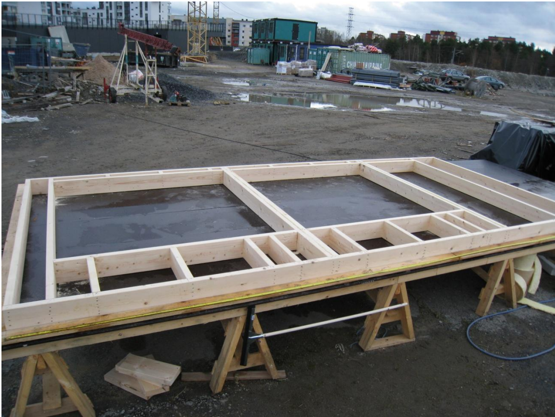
KUVA 2. Valmis runkoelementti
