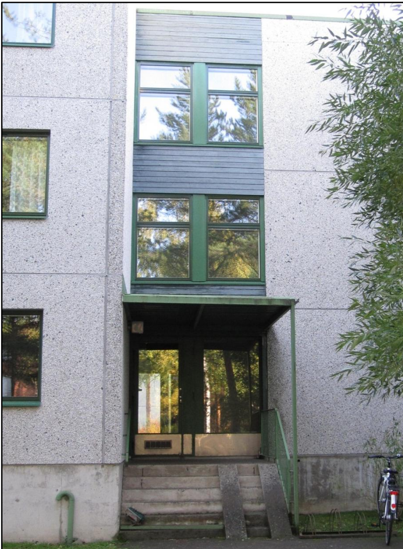
KUVA 25. Porrashuonetyyppiin 4 lukeutuvan rakennuksen julkisivu
