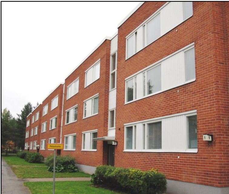
KUVA 11. Porrashuonetyypin 1 rakennusten tyypillinen julkisivu
