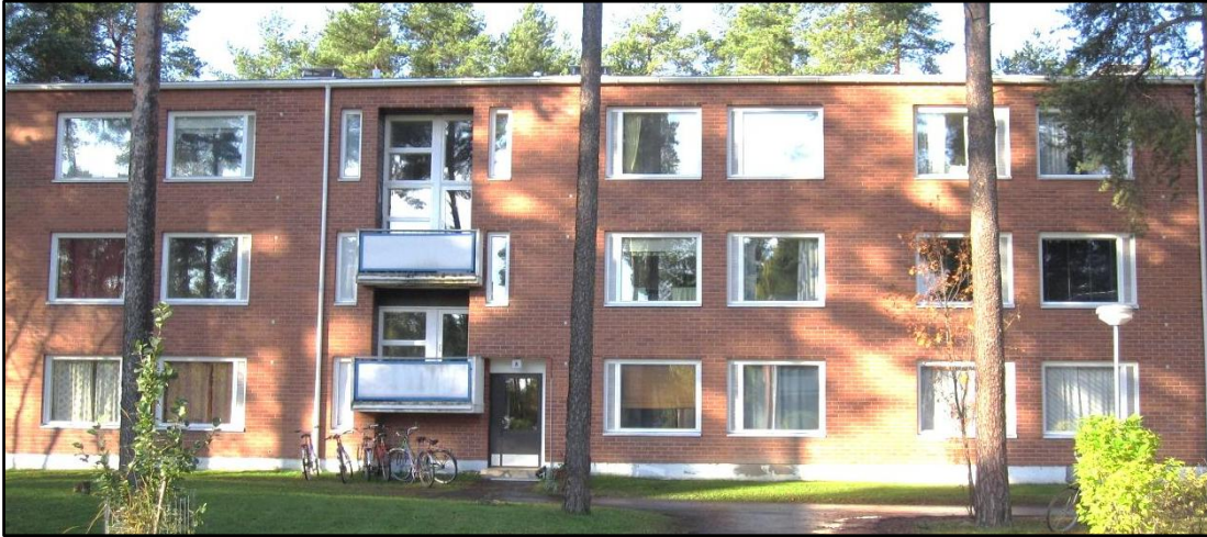
KUVA 21. Porrashuonetyyppiin 3 lukeutuvan rakennuksen julkisivu
