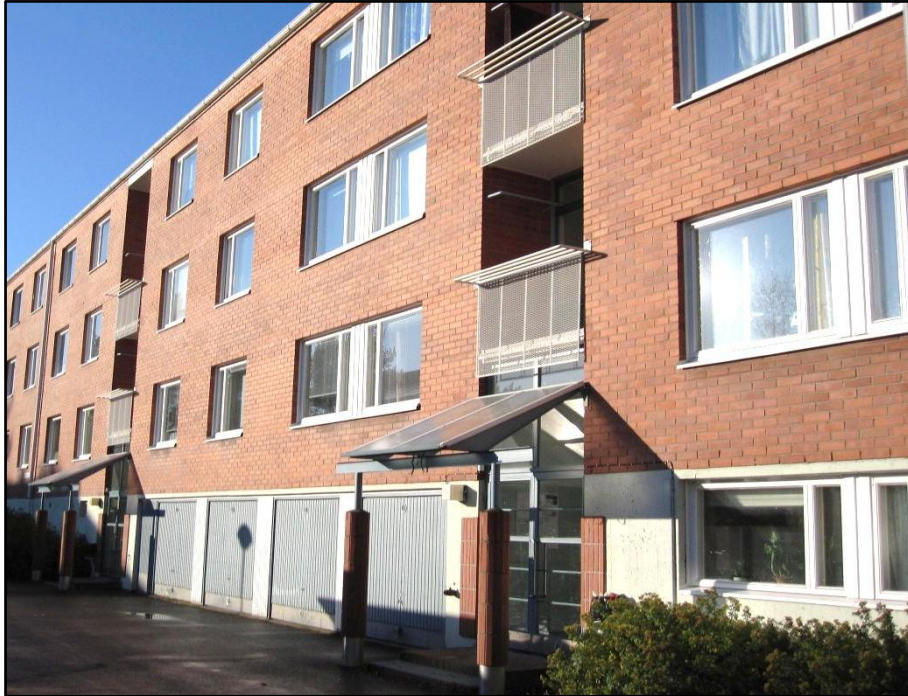
KUVA 29. Esimerkki porrashuonetyypin 5 kuuluvien rakennusten julkisivusta
