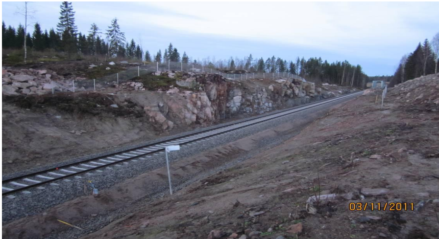
KUVA 16. Viimeistelyä rataa kallioleikkauksessa
