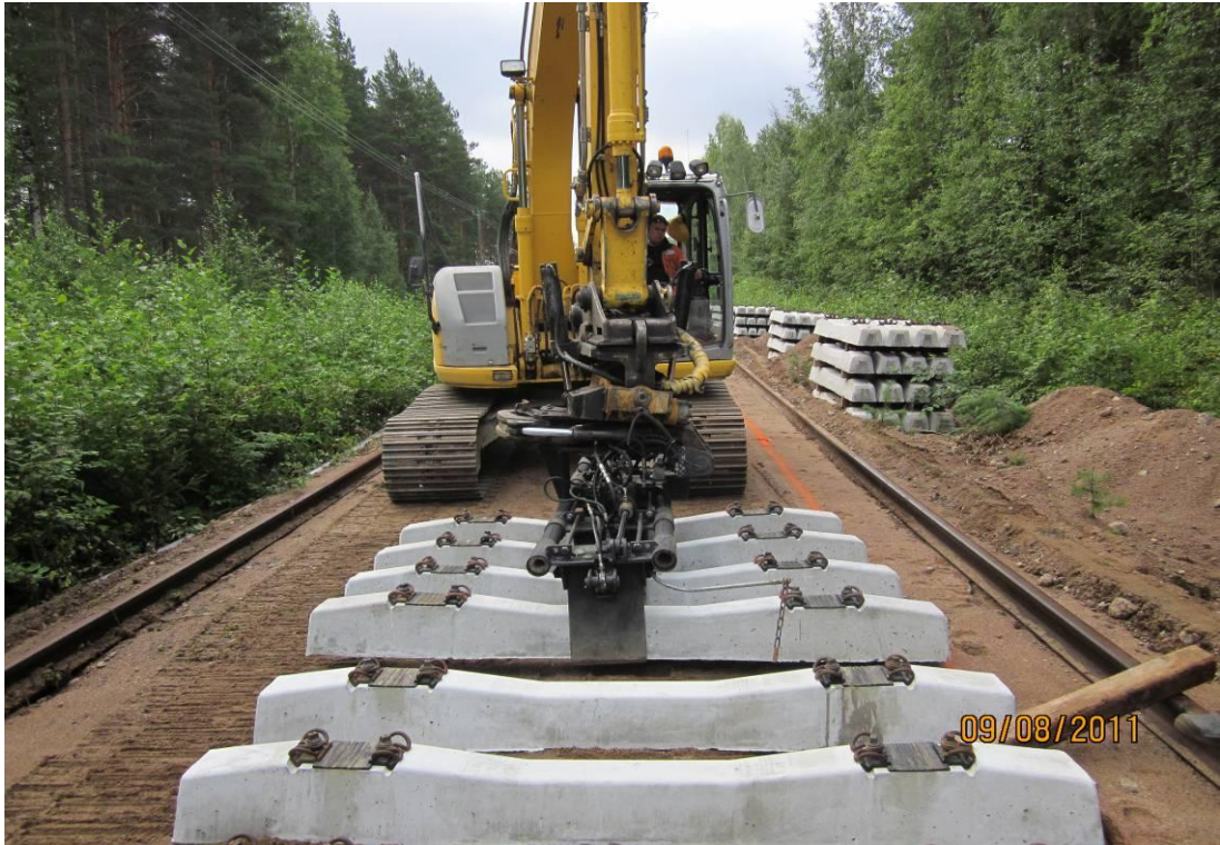
KUVA 10. Pölkynjakolaitteella varustettu tela-alustainen kaivinkone (KKht)
