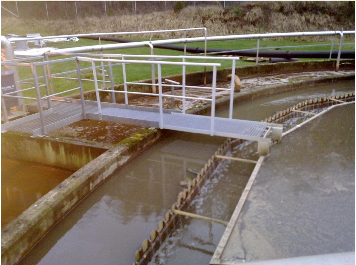
Kuva 5. Karkkilan jätevedenpuhdistamon altaat.
