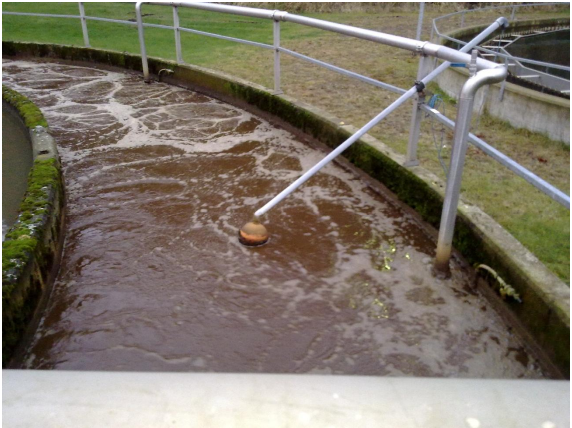
Kuva 4. Ilmastusallas ja happianturi Karkkilan jätevedenpuhdistamolla.
