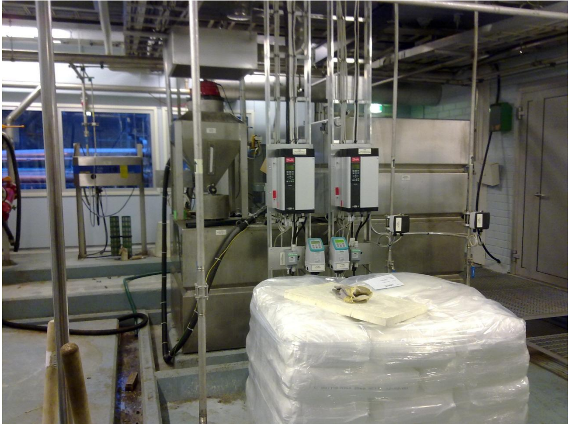
Kuva 3. Kemikalointilaitteisto Karkkilan jätevedenpuhdistamolla.
