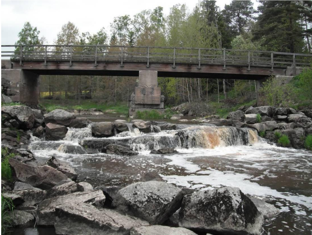
Kuva 20. Kuuskosken silta ja vanha huonokuntoinen myllypato.
