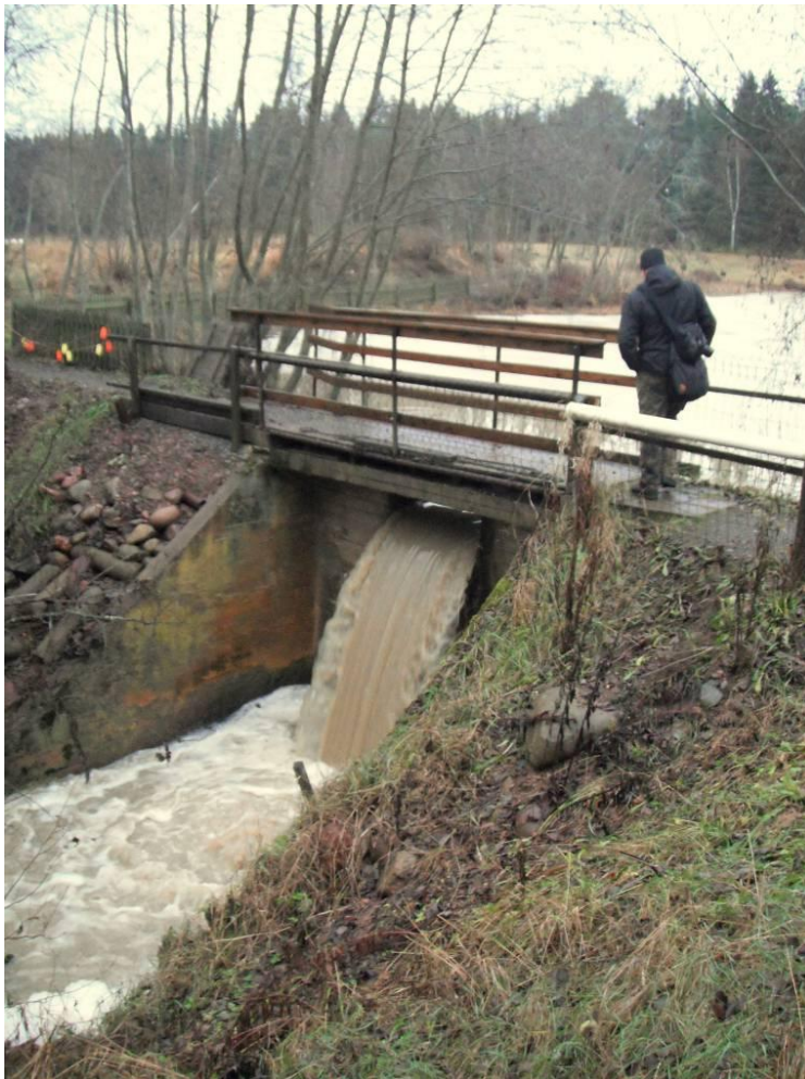
Kuva 33. Korvenojan pato on nousueste. Kuva otettu syystulvan aikaan.
