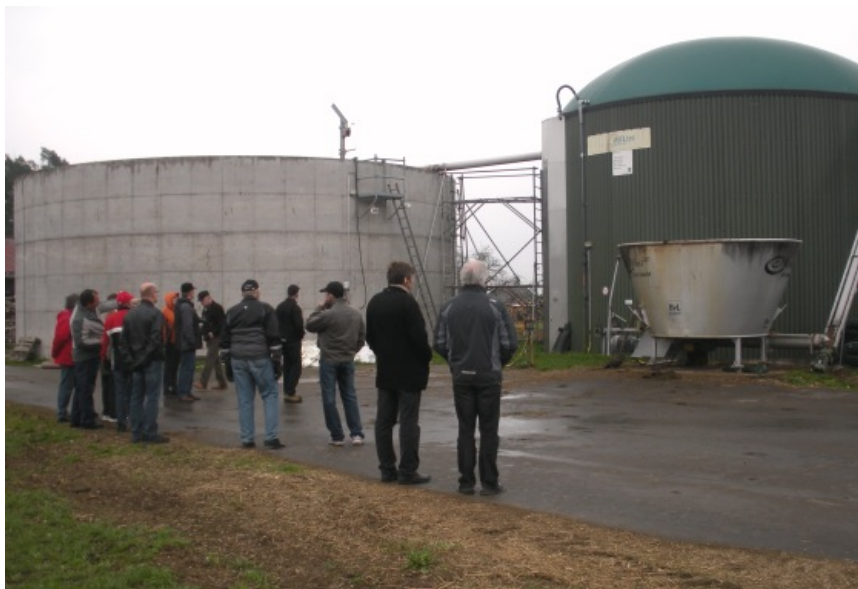
Kuva 1. Erich Sigelin tilan biokaasulaitos ja opintomatikaryhmä. Vasemmalla loppuvarasto, oikealla takana pääreaktori, sen edessä sekoitin ja syöttöruuvi. (Kuva: Ritva Impppola)
