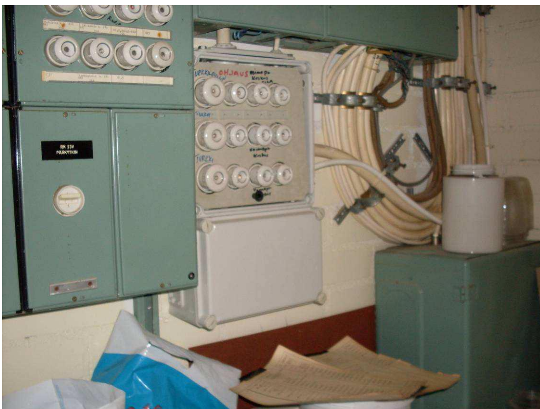
Kuva 10. Turkkilaisen saunan sulakkeet
