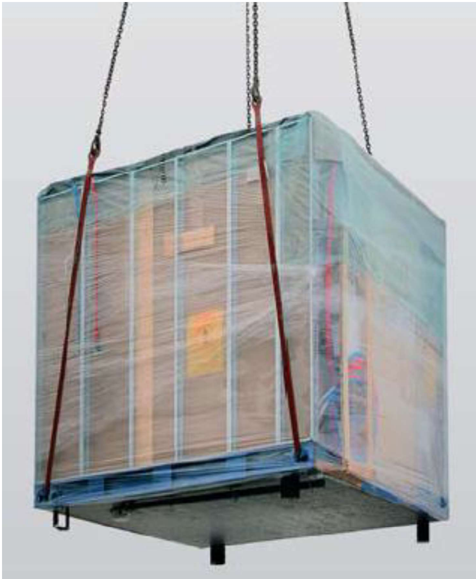
Kuva 5.1 Part Construction Ab:n valmistama kylpyhuone-elementti suojattuna muovilla kuljetusta ja säilytystä varten (Part Construction Ab 2010, 1)
