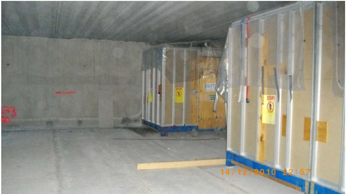
Kuva 6.2 Kylpyhuone-elementit HC Saimaa -kylpylähotellin työmaalla (SRV Rakennus Oy valokuva 2010)
