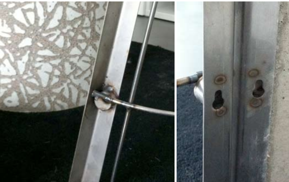
Elementtien kiinnitysreikä ja tausta kolo. Kaksi elementtiä kiinnitetään toisiinsa kartion sisäpuolelta "avainrei"istä" erillisellä kiinnityskappaleella.
