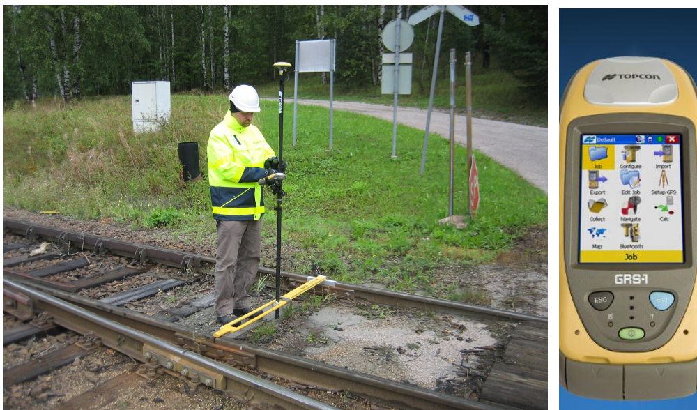
Kuva 10. Kuvassa näkyy raiteen keskilinjän mittausta Äänekoskella syksyllä 2010.
