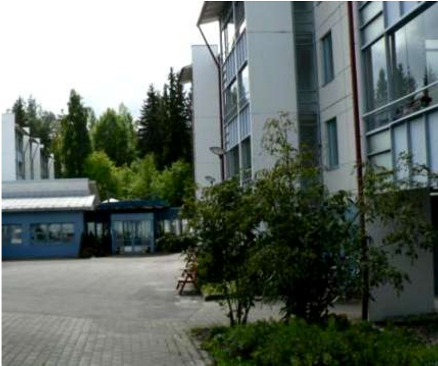
Kuva 3. Kangasvuokon kahta taloa yhdistävä matala laajennusosa (Kuva: Jaana Nykänen).
