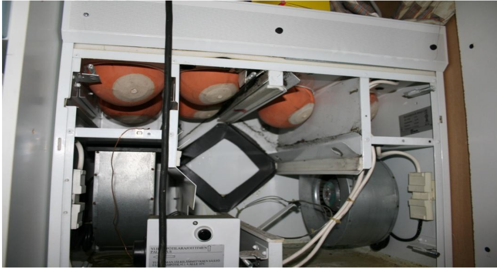
Kuva 11. Ilmanvaihtokoneen tiivistäminen pallon sisäkumilla (Lautkankare 2011b, 46).
