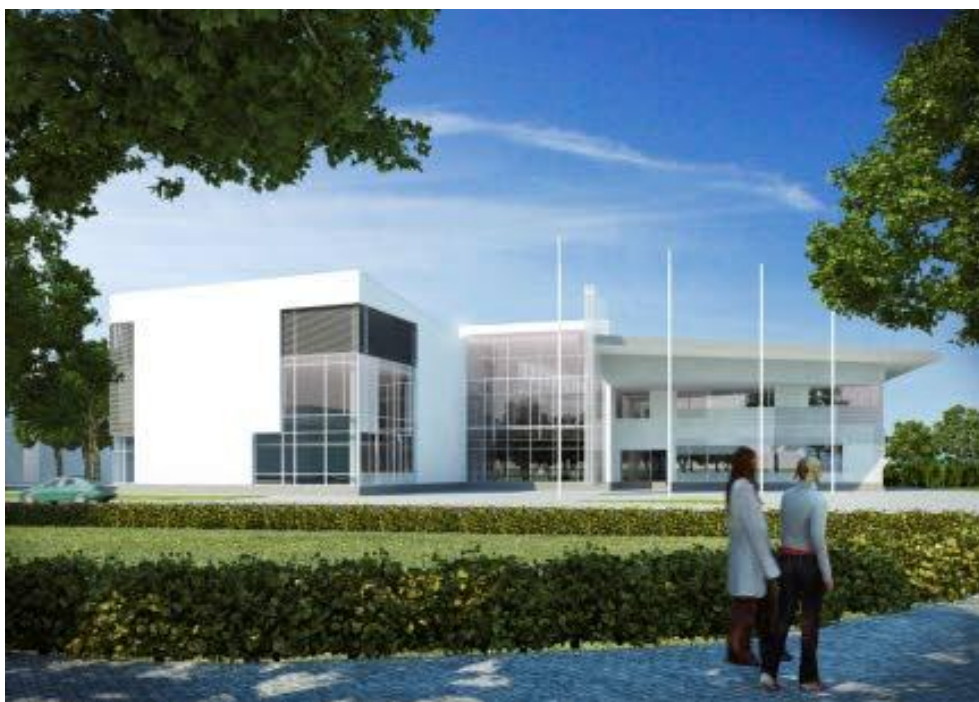
Kuva 13. Salon kaupungintalo (NCC Rakennus Oy 2010b, 1).
