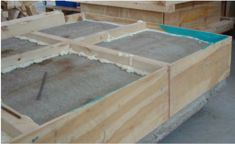
KUVA 15. Ontelolaatan päälle rakennettu muotti pintalattioita kuvaaville pienlaatoille
