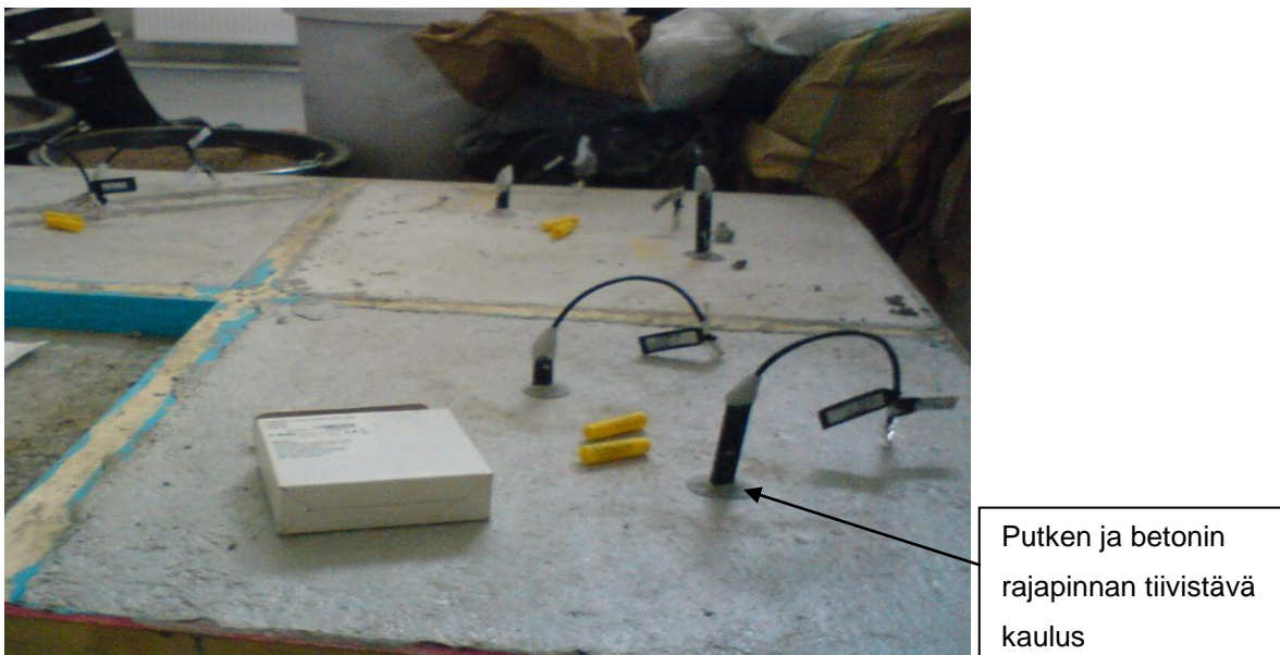
KUVA 9. Betonin suhteellisen kosteuden mittaus porareikämenetelmällä
