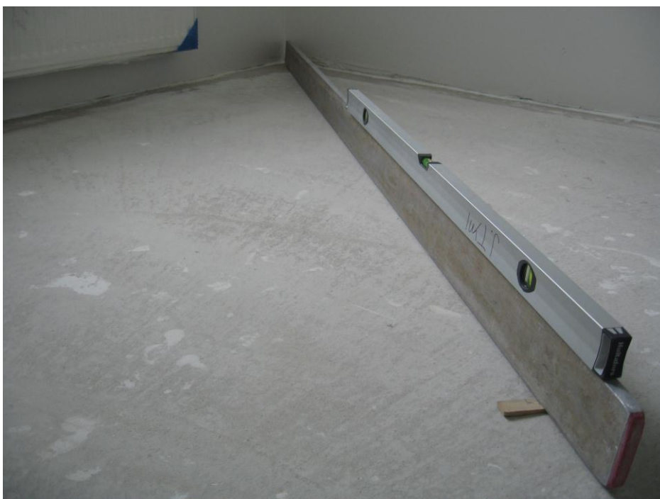
KUVA 27. Maanvastaisen lattian nurkkien kohouman mittaus linjaraudalla, vesivaa`alla ja mittakorokkeella
