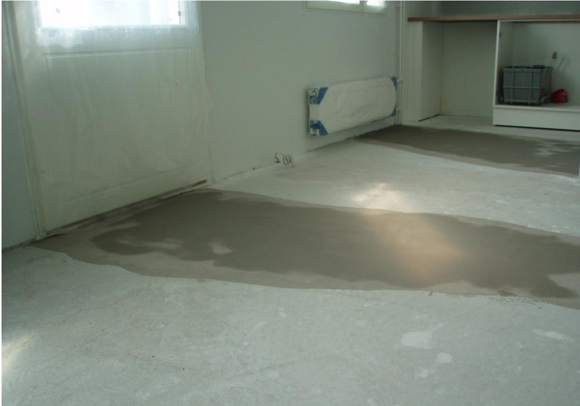
KUVA 12. Pintalattian epätasaisuudet on tasoitettu lattiatasoitteella
