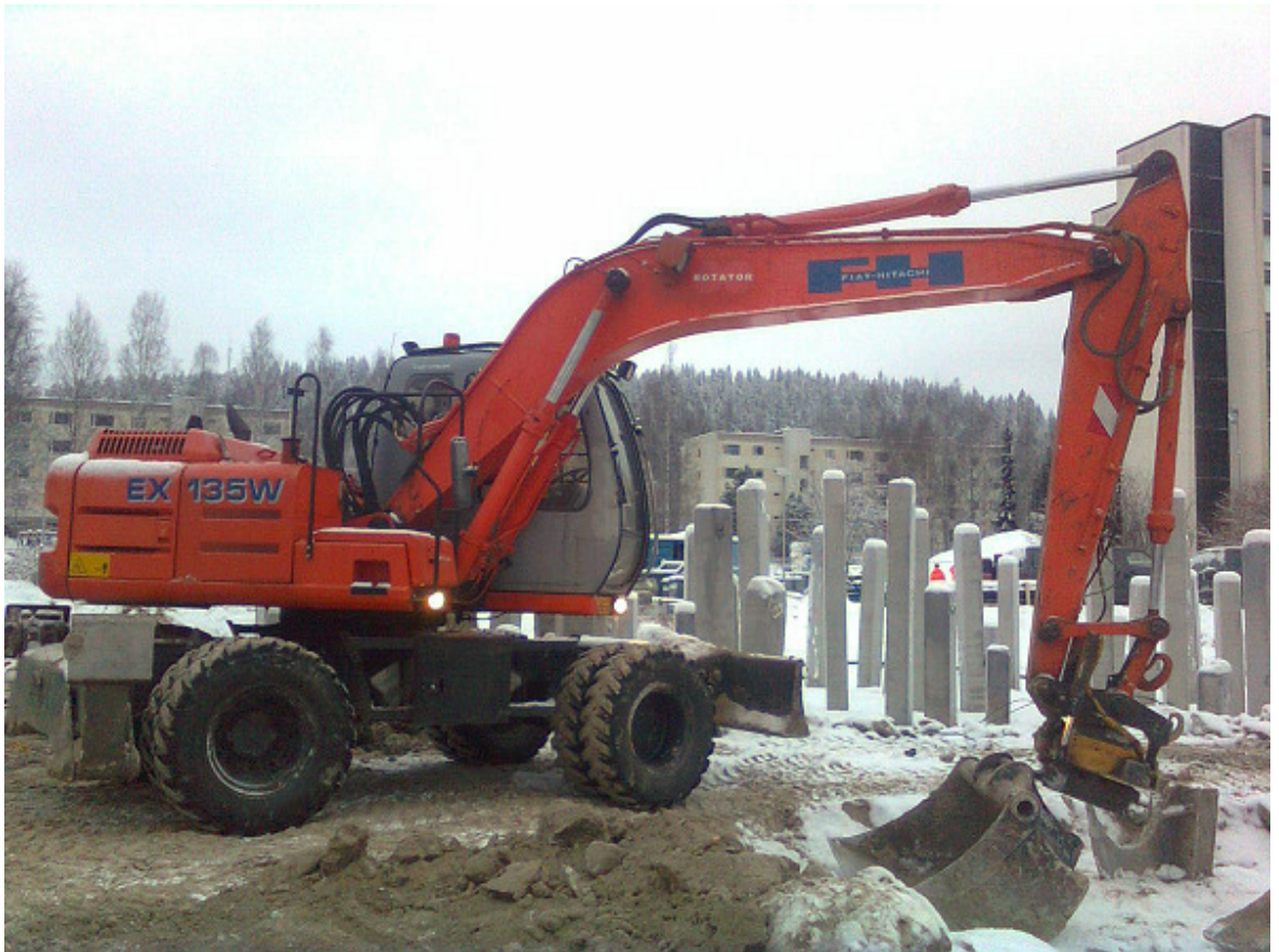
Kuva 9. Maajukka Oy:n pyöräalustainen kaivinkone Fiat Hitachi EX 135 W Jyväskylän Lutakon työmaan paalutustöissä.
