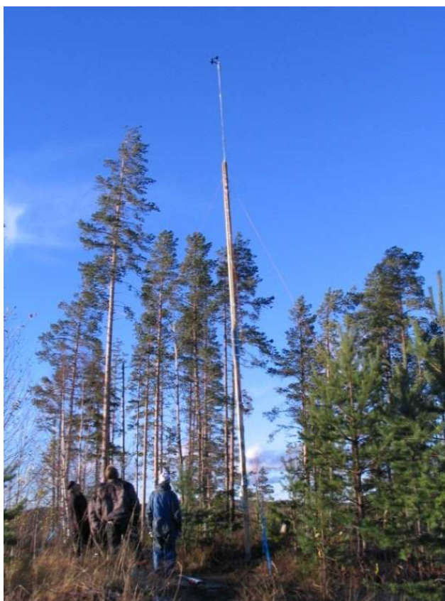
Kuva 204. Pystytysporukka ja Terttulanvaaralle juuri pystytetty 13 metrinen tuulimittausmasto.
