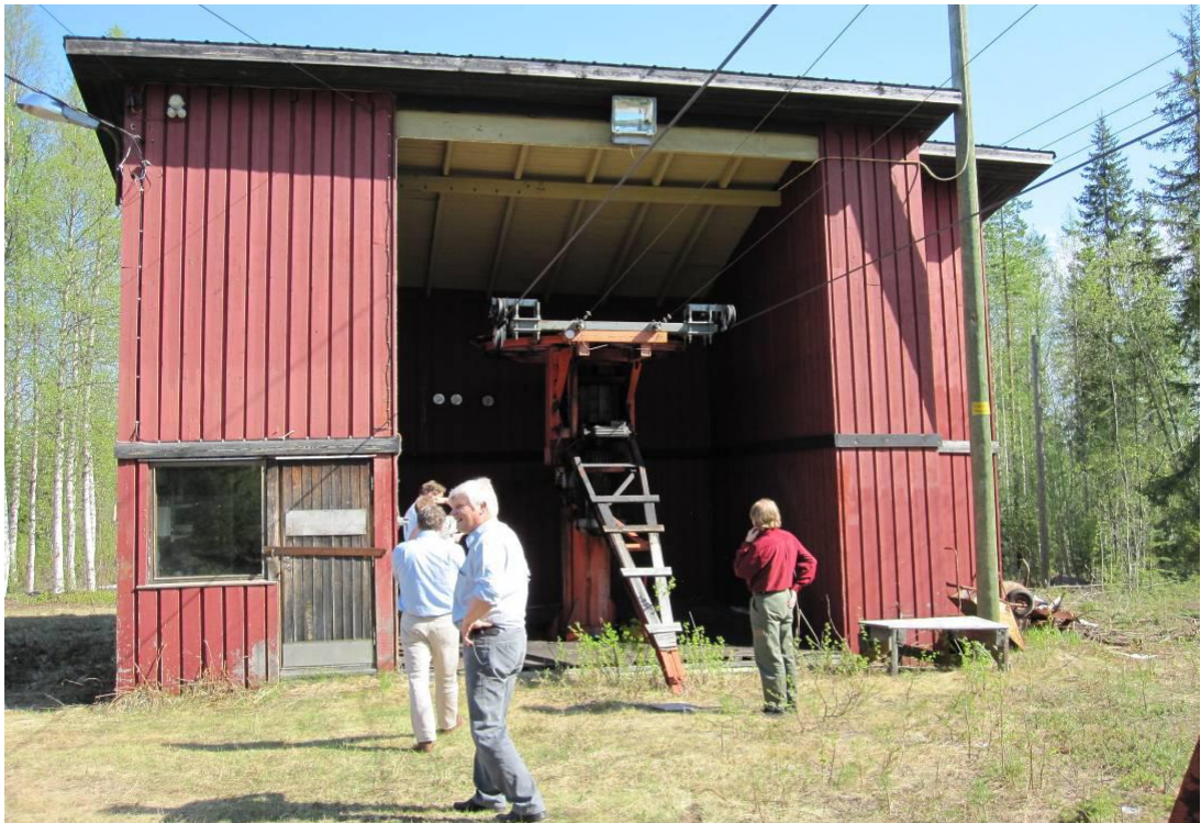
Kuva 2. Vanhan hissin ala-asema (Kurttila 2010, 2).
