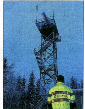
5 kilometrin päässä lentokentältä sijaitsee toisiotutka, josta pystytään lähettämään kuvaa lennonjohtoihin ympäri Suomea.
