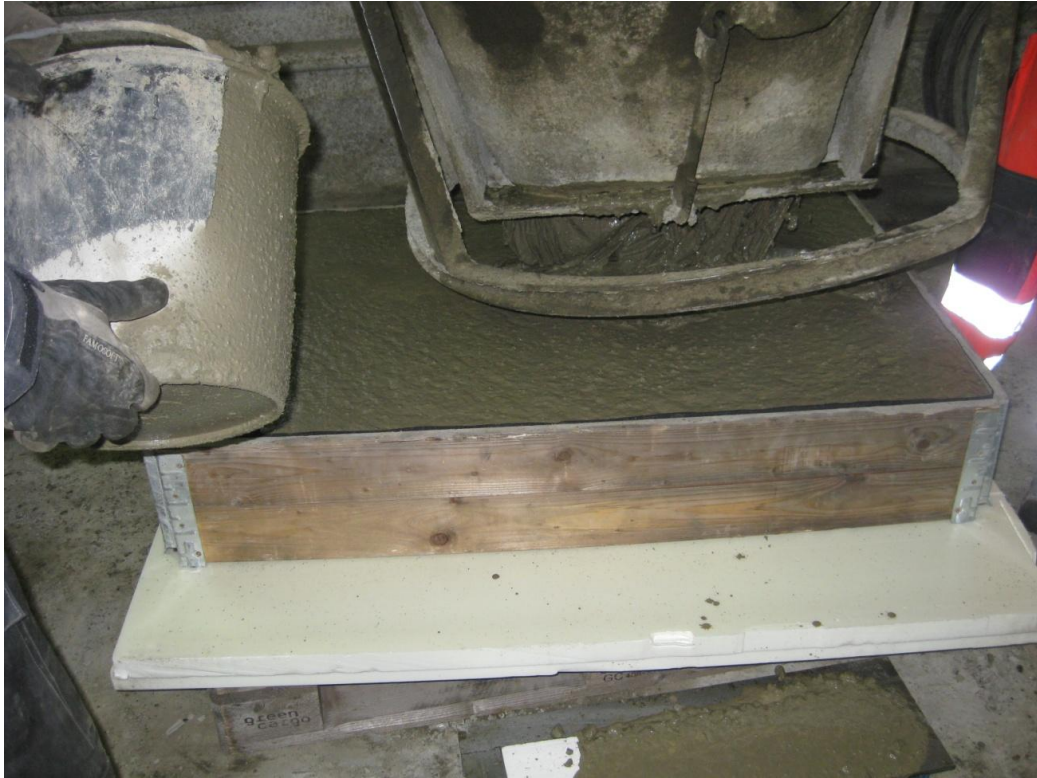
Kuva 8. Tutkimuslaattojen valu nostoastialla.
