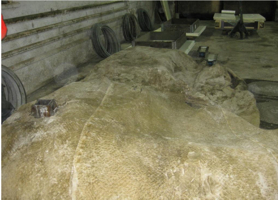
Kuva 9. Betonin jälkihoito suojaamalla.
