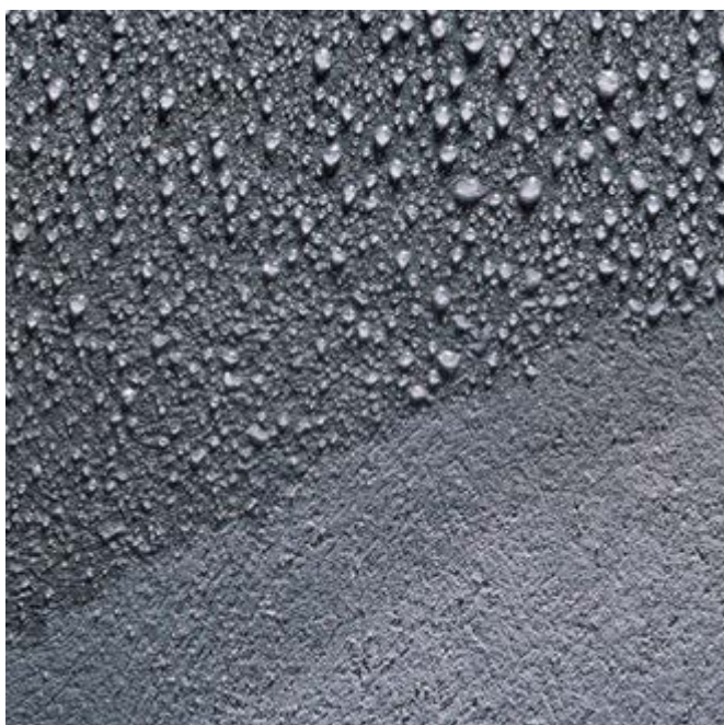
KUVA 44. Impregnoitu betonipinta (STOFI 2012)
