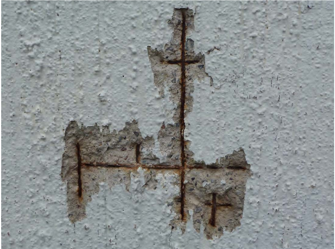
KUVA 40. Betonin halkeilua (Vesterinen 2012, 12)
