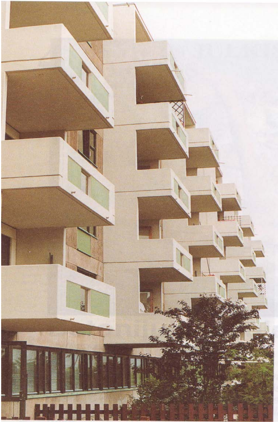
KUVA 42. Laastipaikkaus (Julkisivuyhdistys ry 1997, 64)
