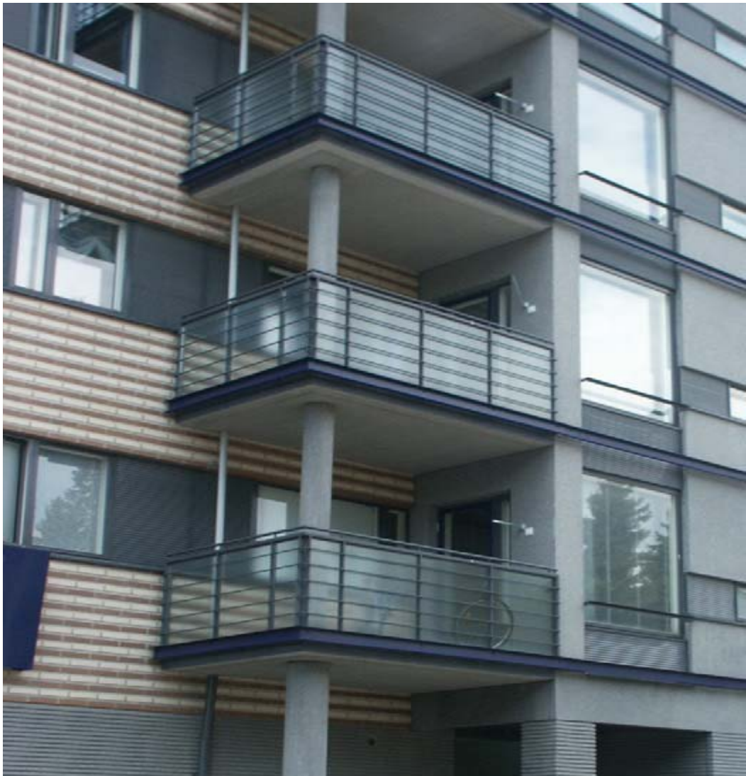
KUVA 15. Pilarin ja pieliseinän kannattama parveke (Betoniteollisuus ry 2010, 12)
