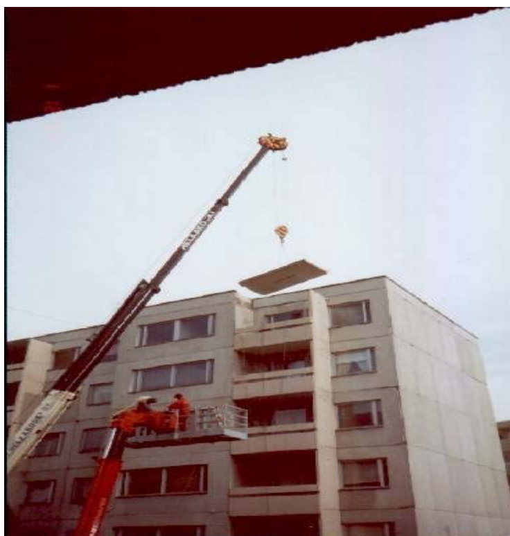
KUVA 45. Elementtiparvekkeen purku (RTEK-3730 2009, 69)
