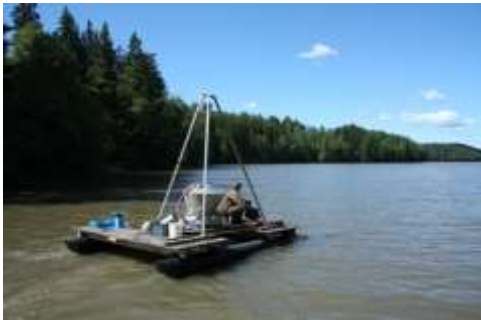
Kuva 46. Hapetuslaitteen asennus (Kuva: Kekkonen 2010)
