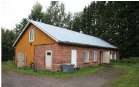
Kuva 19. Nykyinen tallirakennus (Kuva: Mustialan opiskelijat 2011)
