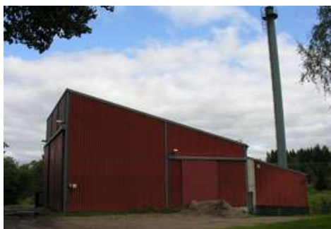
Kuva 15. Lämpökeskus (Kuva: Mustialan henkilökunta 2008)
