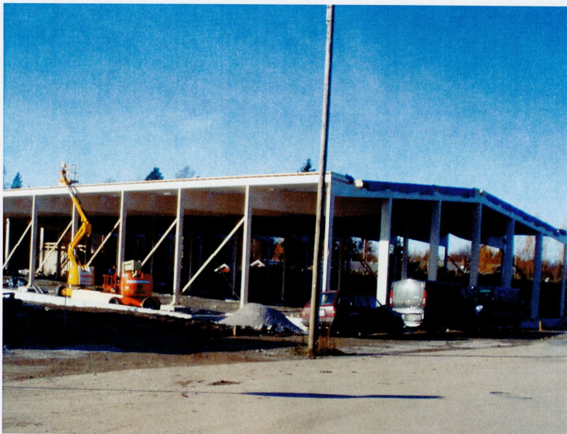
Kuva 3. Kattoelementit asennettuna liikeosaan.
