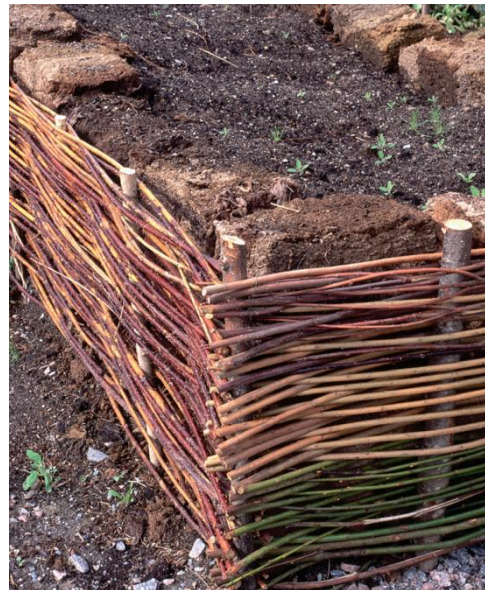
Kuva 53. Turveharkkojen latominen punotun aidan sisäreunalle on hyvä keino estää maa-ainesta valumasta aidan raoista.
