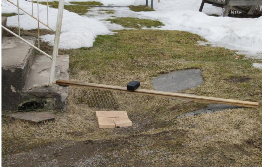
Kuva 44. Routa voi savisilla mailla aiheuttaa suuriakin kohoumia maahan. Näiden rappusten edusta on kesällä tasainen. Tällaiseen paikkaan rakennettu suojaamaton muuri vaurioituisi takuuvarmasti.
