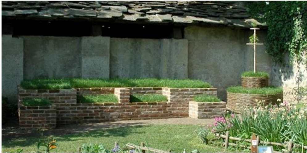
Kuva 51. Torinon keskiaikaiseen kaupunginosaan rakennetussa puutarhassa nurmipenkki on toteutettu näin. Oikealla puolella on myös punosaidalla tuettu kohopenkki pientä puuta varten, jollainen näkyy kuvassa 24.
