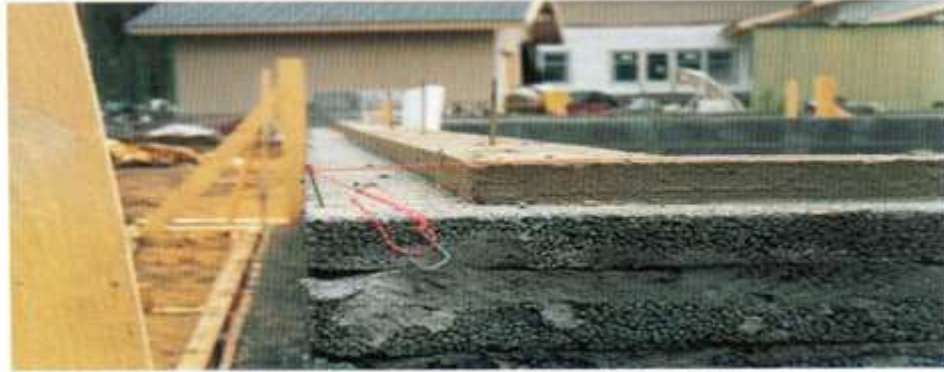
Kuva 1. Esimerkki "Pientalotyömaan valvonta ja tarkastusasiakirjan" yksityiskohtaisista ohjeista. Kirjan kuvatekstissä ohjeistettiin yksityiskohtaisesti, kuinka aluspuu nostetaan julkisivumuurausta ylemmäksi, ettei aluspuu kastuisi veden johdosta. [6, s. 48.]
