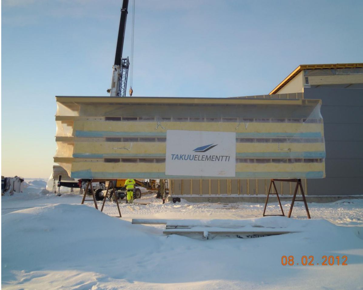
KUVA 5. Päätoimijaan kuuluvan Takuuelementin kattoelementti
