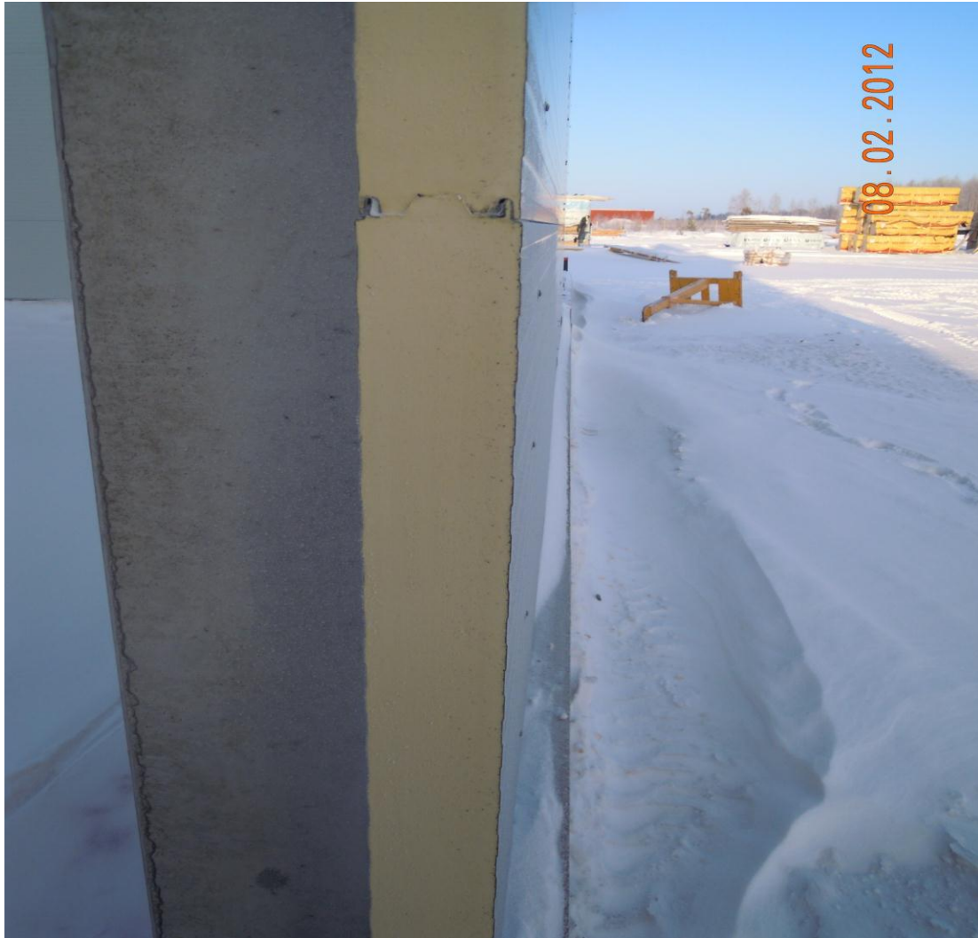
KUVA 6. Lämpimän tilan seinäelementti
