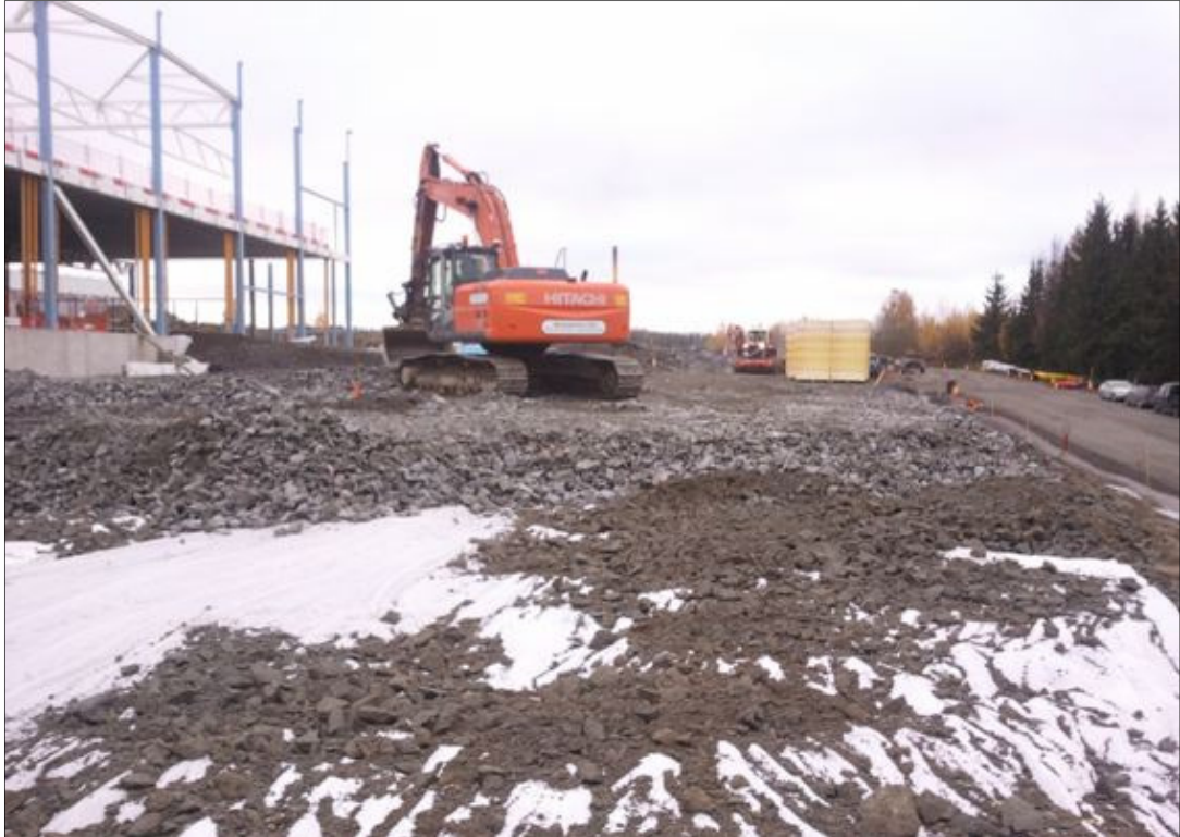
KUVA 28. Jakavan kerroksen levitystä Tamron työmaalla 21.10.2011
