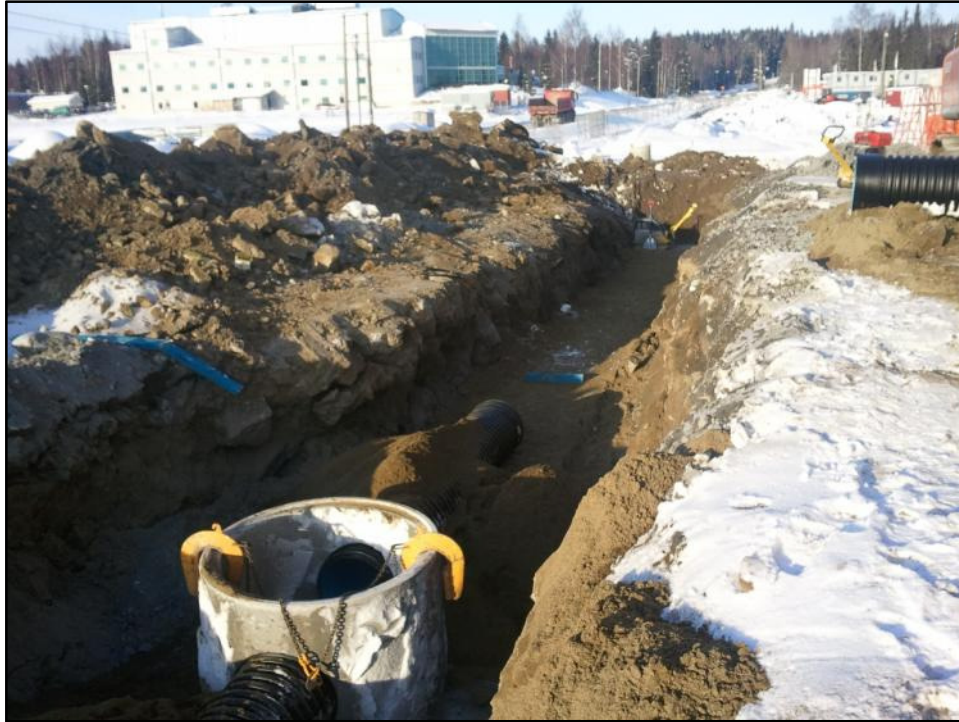
KUVA 32. Sadevesilinjan teko käynnissä Cargotecilla
