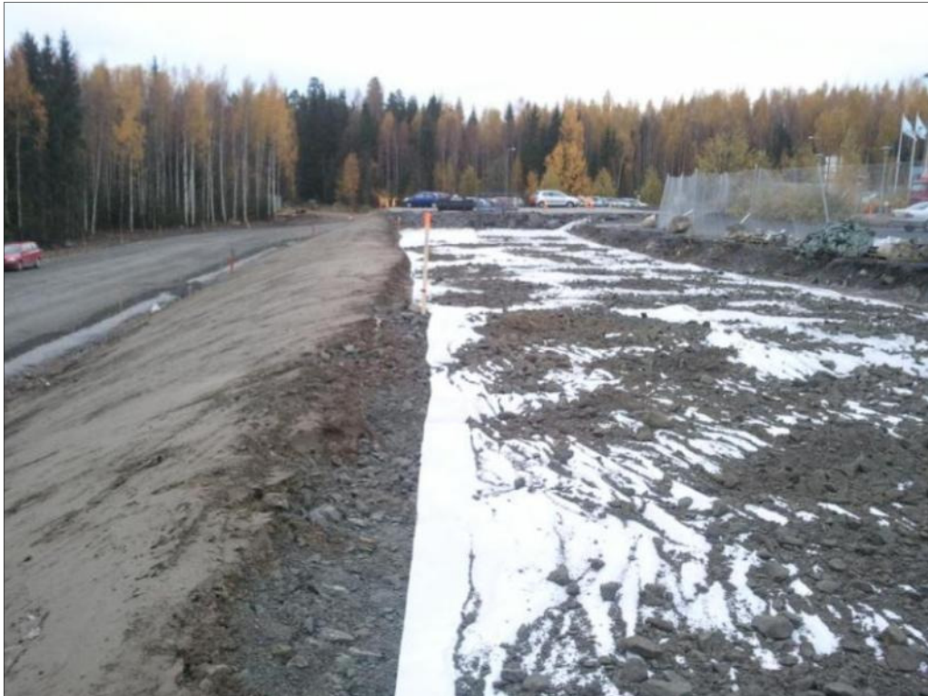
KUVA 27. Liikennealue rakennekerrosten alapinnassa Tamron työmaalla 21.10.2011
