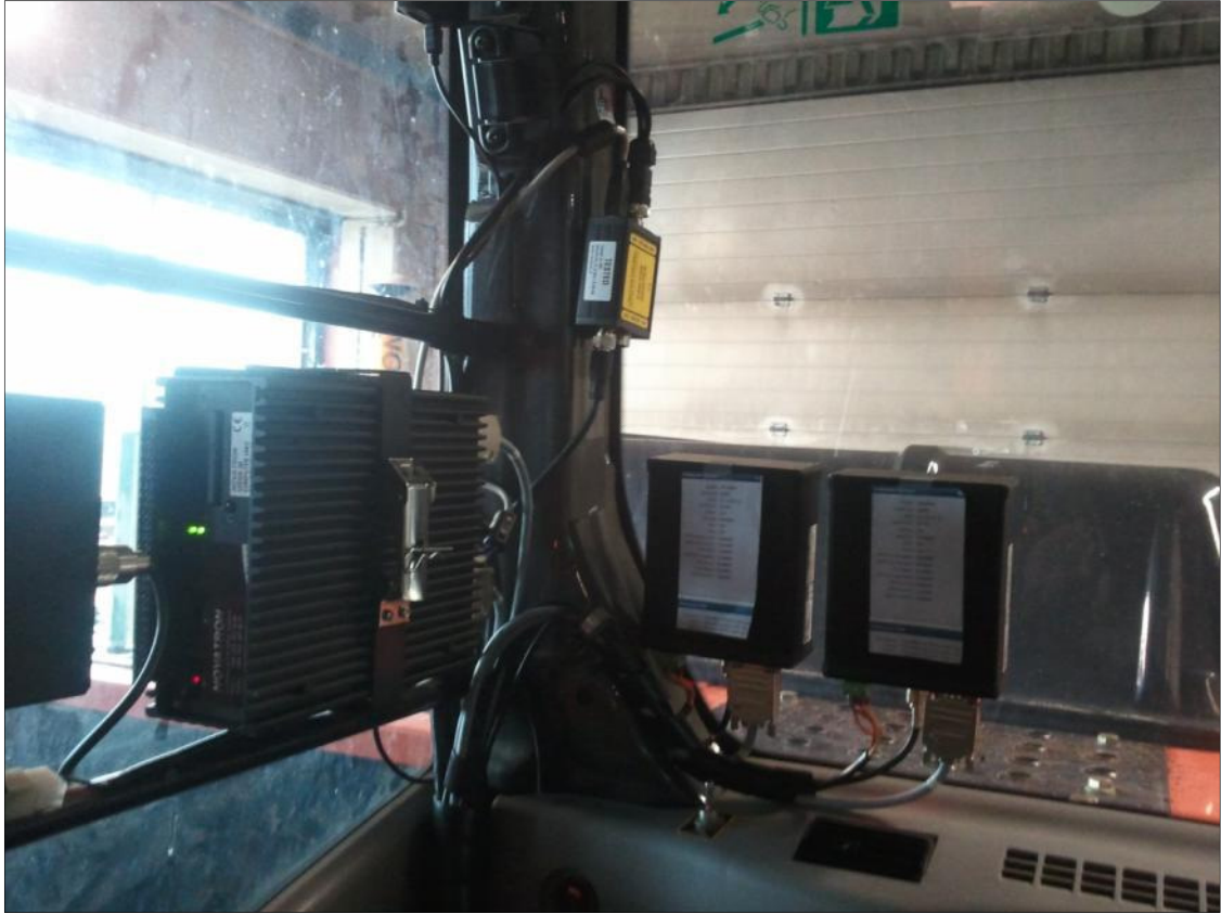
KUVA 8. Kaivinkoneen hyttiin asennetut laitteiston osat 2.4.2011
