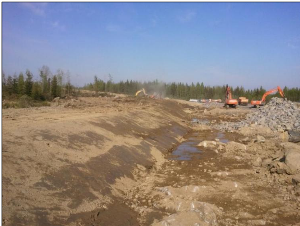
KUVA 25. Korkoonsa leikattua rakennuspohjaa Tamron työmaalla 13.05.2011
