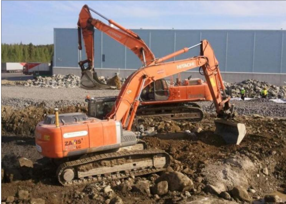
KUVA 24. Maaleikkaustyöt käynnissä Tamron työmaalla 12.05.2011
