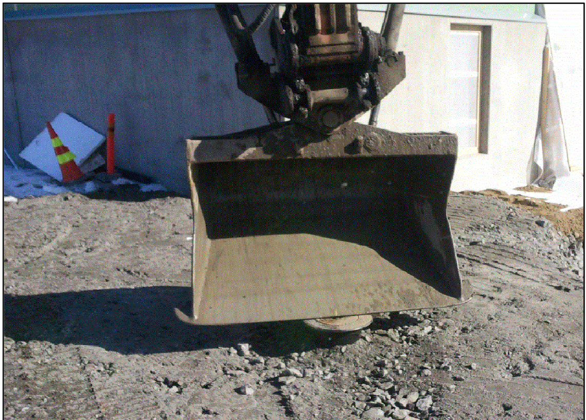
KUVA 35. Tarkemittauksen otto sadevesikaivon kannesta
