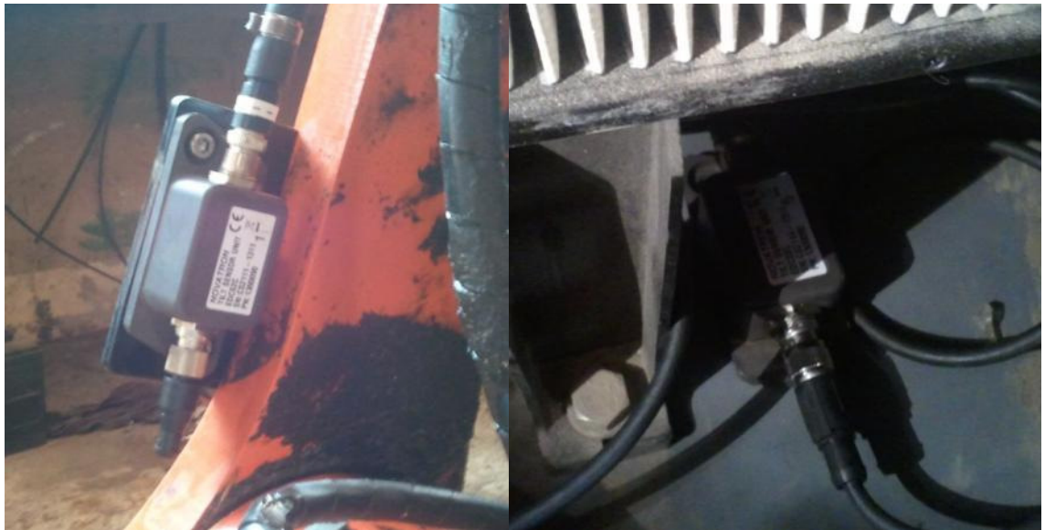
KUVA 7. Koiranluuhun ja koneen hyttiin asennetut anturit 2.4.2011
