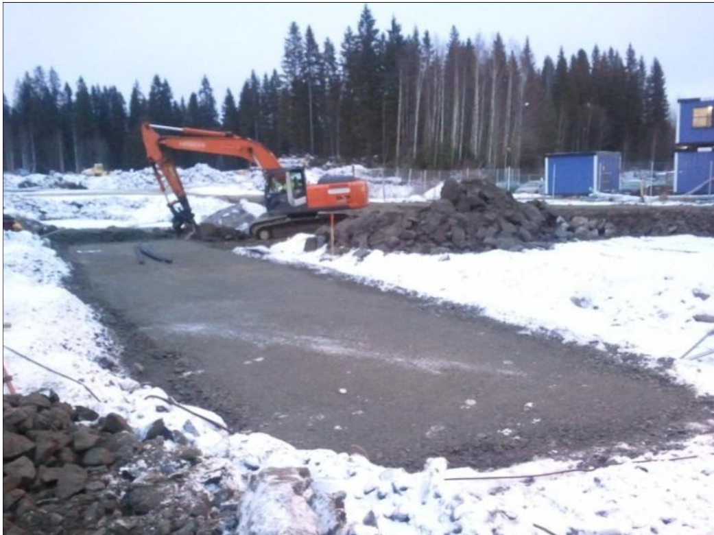
KUVA 30. Anturoiden pohjien tekoa Cargotecin työmaalla 21.12.2011
