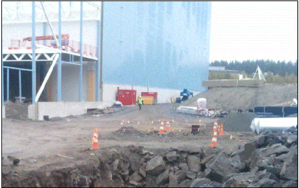
KUVA 36. Katvealue Tamron työmaalla
