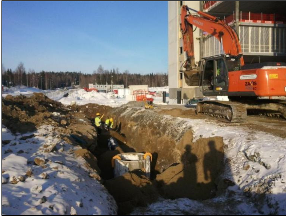
KUVA 33. Sadevesilinjan putken asennus käynnissä Cargotecilla
