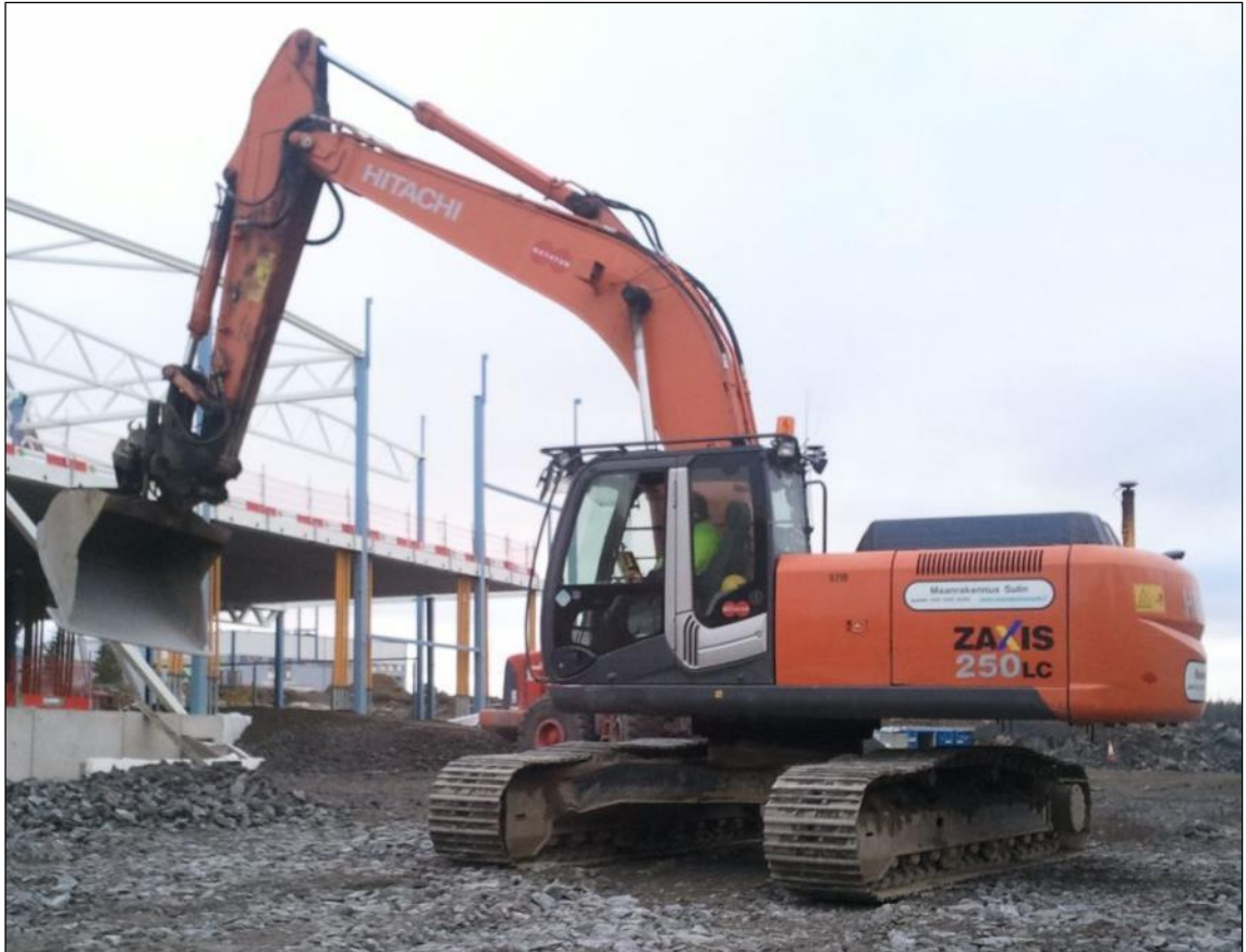
KUVA 3. Tela-alustainen kaivinkone Hitachi ZX 250LC
