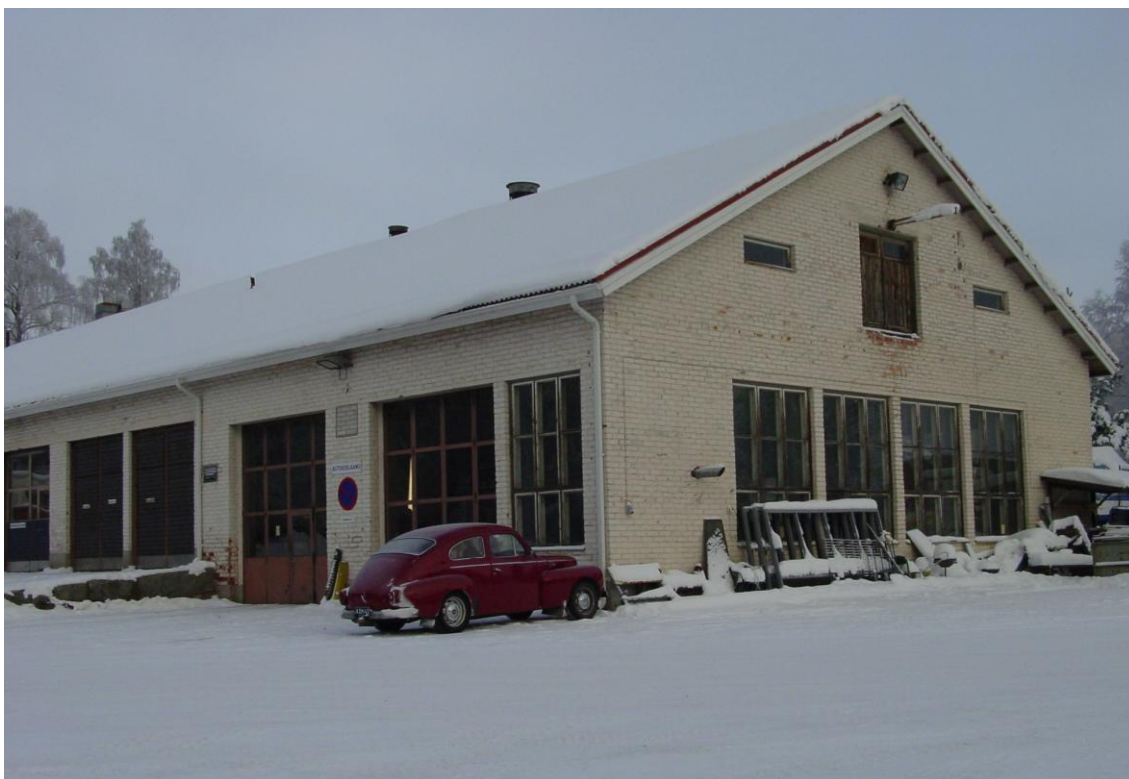
Kuva 1. Konekeskuksen korjaamotilat tammikuussa 2012
