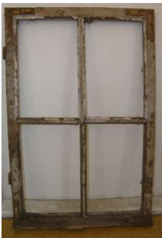
Kuva 11. F-seinän ikkuna ulkopuolelta. (Sundman 2012)
