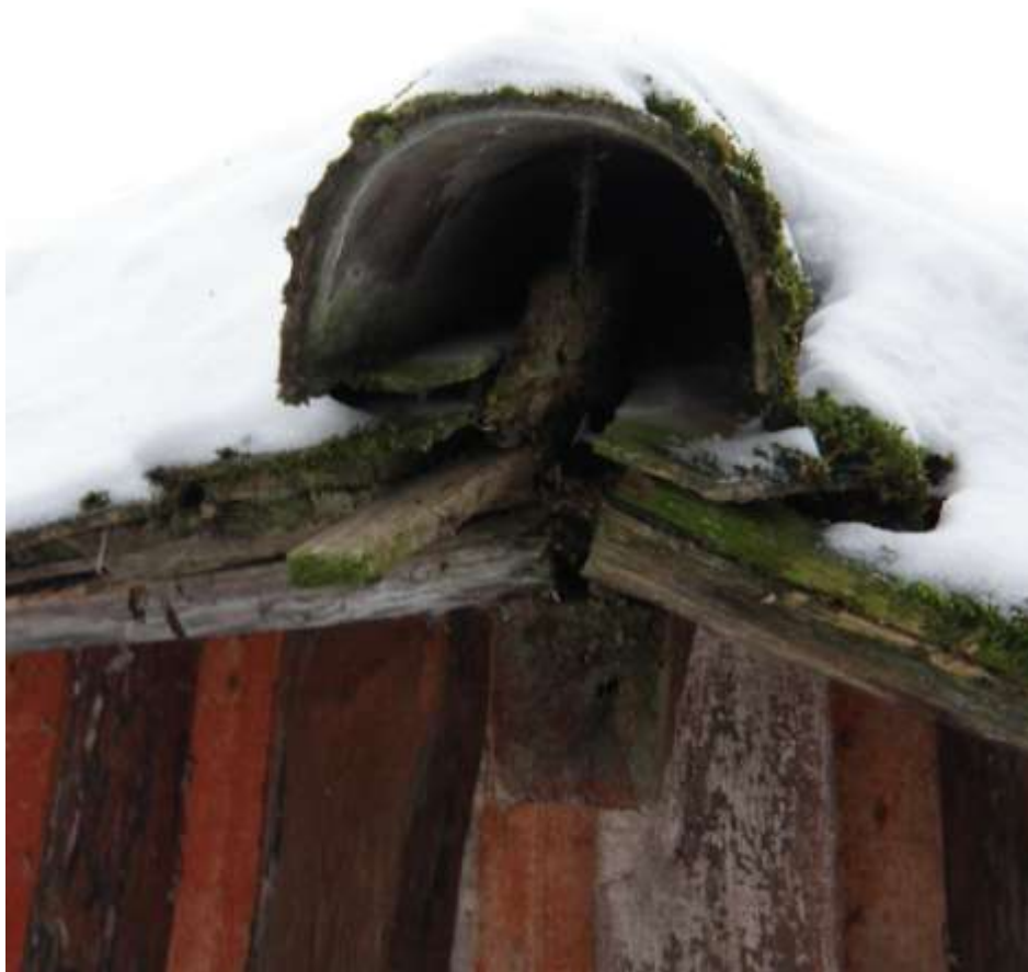
Kuva 6. Katon kulmaa suojaa kaareva mineriittilevy. (Sundman 2012)
