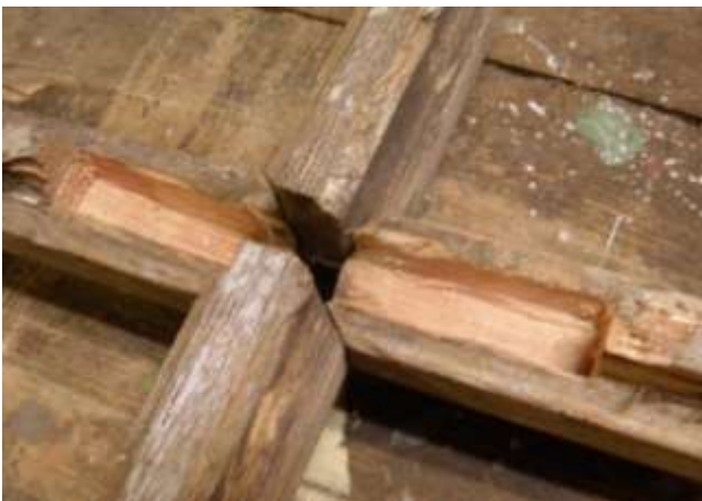
Kuva 3. Murtunut välipuite korjattiin talttaamalla kouru johon upotettiin sopivaksi veistetty korjauspala. (Sundman 2012)
