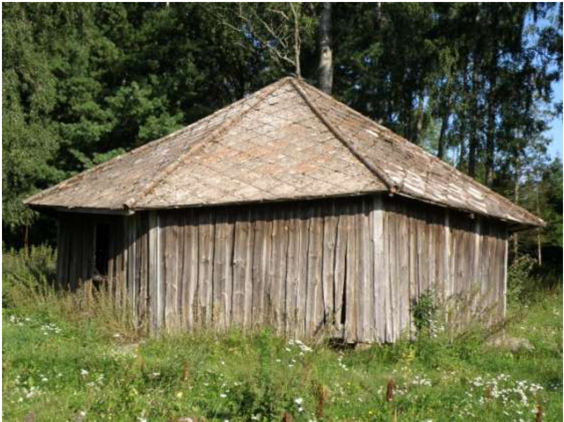
Kuva 3. Yleiskuva pumpputalosta D-seinän suunnalta. (Sundman 2011)
