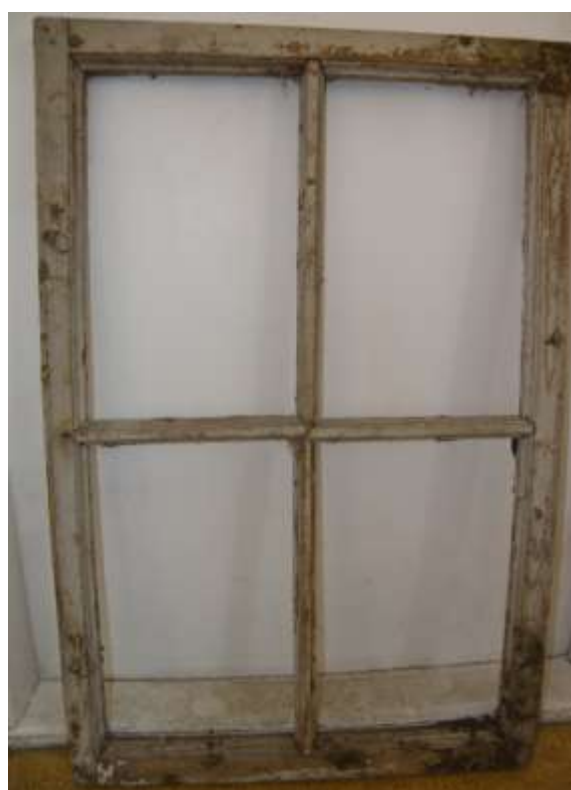
Kuva 12. F-seinän ikkuna sisäpuolelta. (Sundman 2012)
