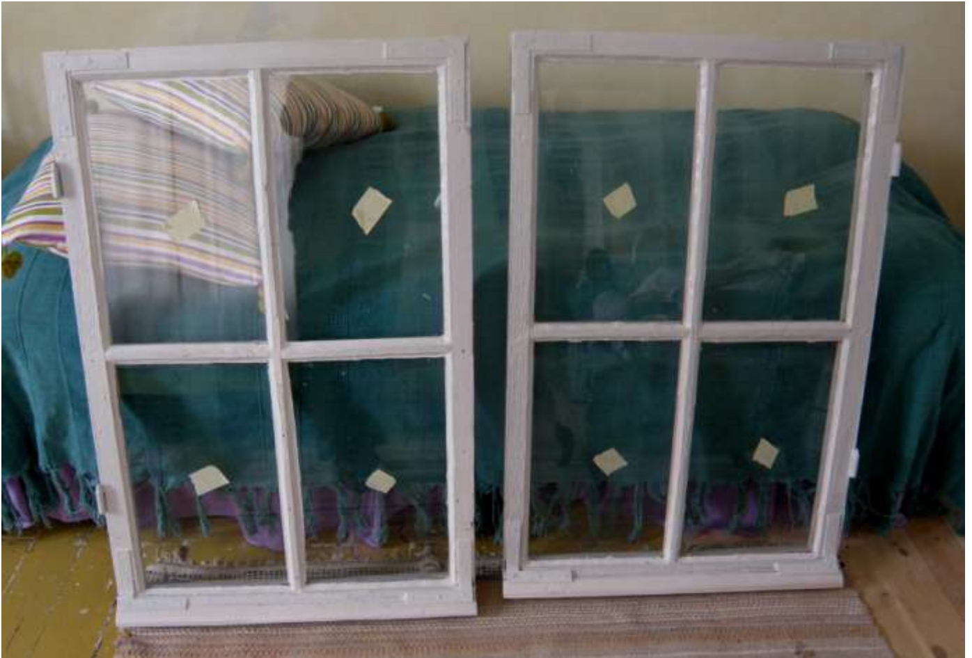
Kuva 1. Ikkunat restauroinnin jälkeen. Vasemmalla F-seinän ikkuna. (Sundman 2012)
