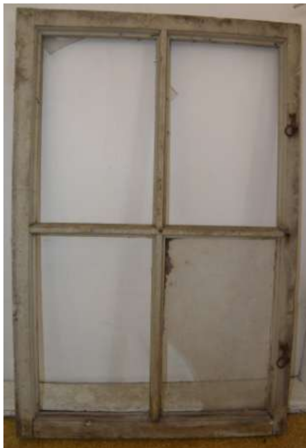
Kuva 14. C-seinän ikkuna sisäpuolelta. (Sundman 2012)
