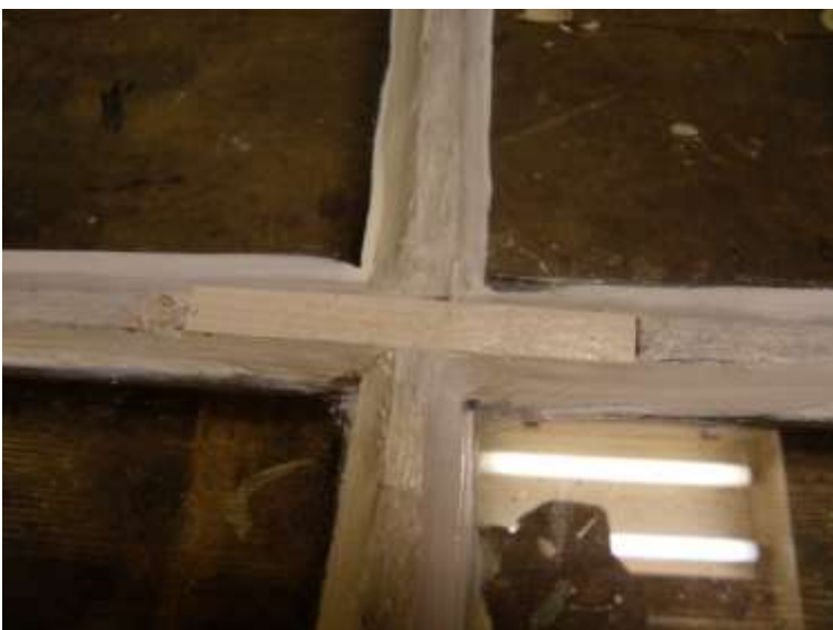
Kuva 4. Välipuite korjattuna ja pohjamaalattuna. (Sundman 2012)
