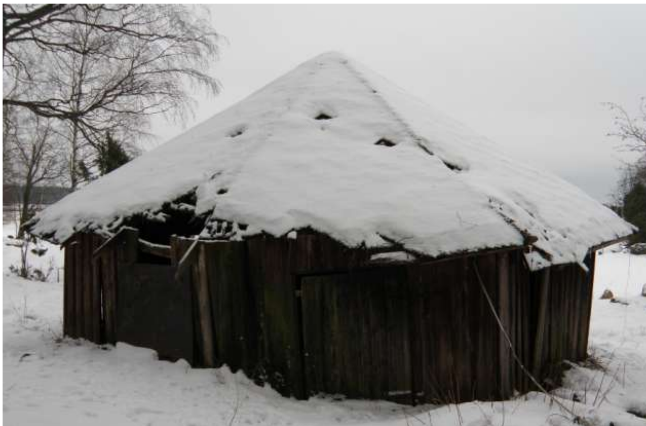
Kuva 1. Yleiskuva sivu A. (Sundman 2012)
