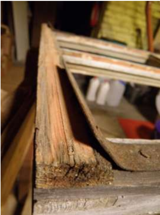
Kuvat 1 ja 2. Alapuitteesta sahattiin vaurioitunut osa irti ja korvattiin se uudella höylätyllä tippalistalla. (Sundman 2012)
