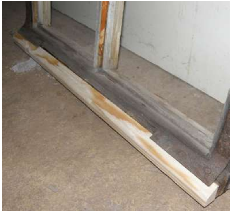
Kuvat 1 ja 2. Alapuitteesta sahattiin vaurioitunut osa irti ja korvattiin se uudella höylätyllä tippalistalla. (Sundman 2012)
