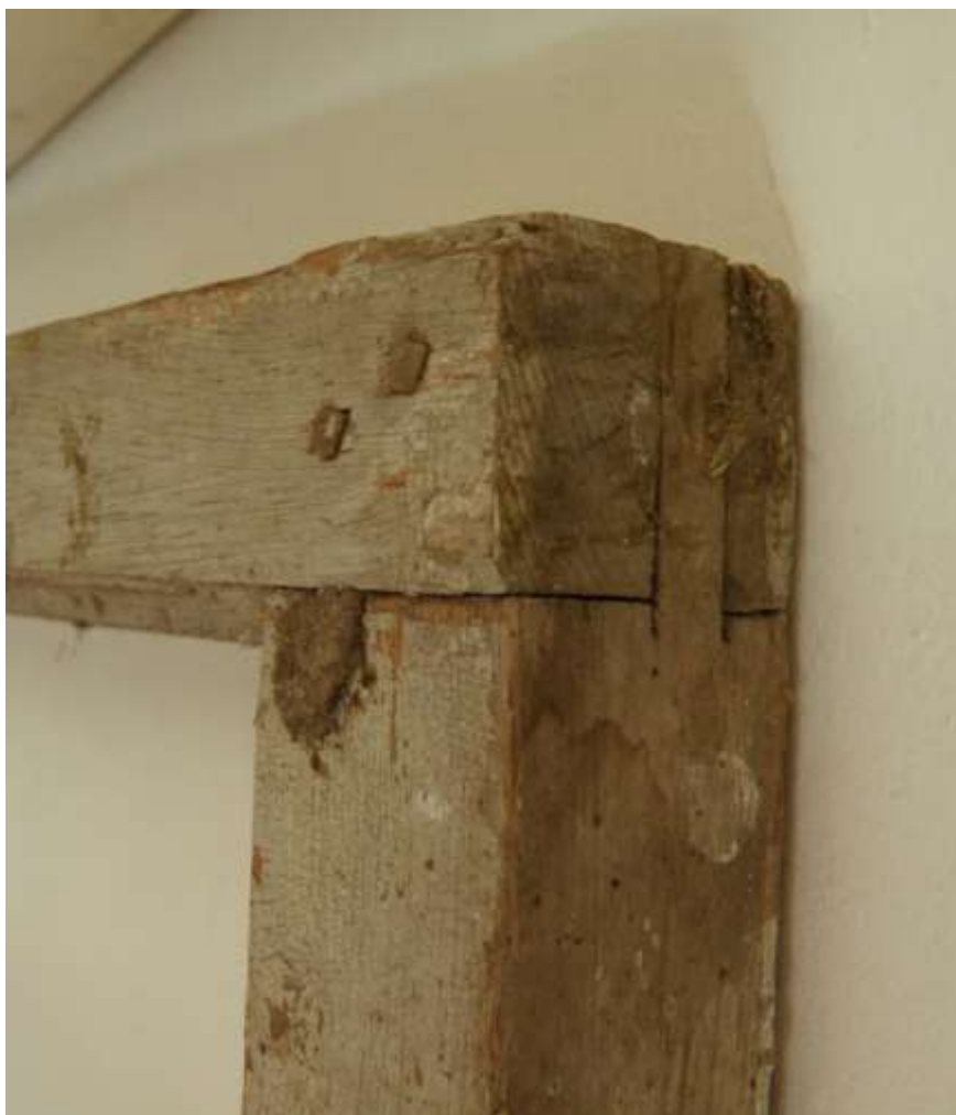
Kuva 15. C-seinän ikkunan sisäpuolella on jäänteitä vaaleanharmaasta öljymaalista. (Sundman 2012)
