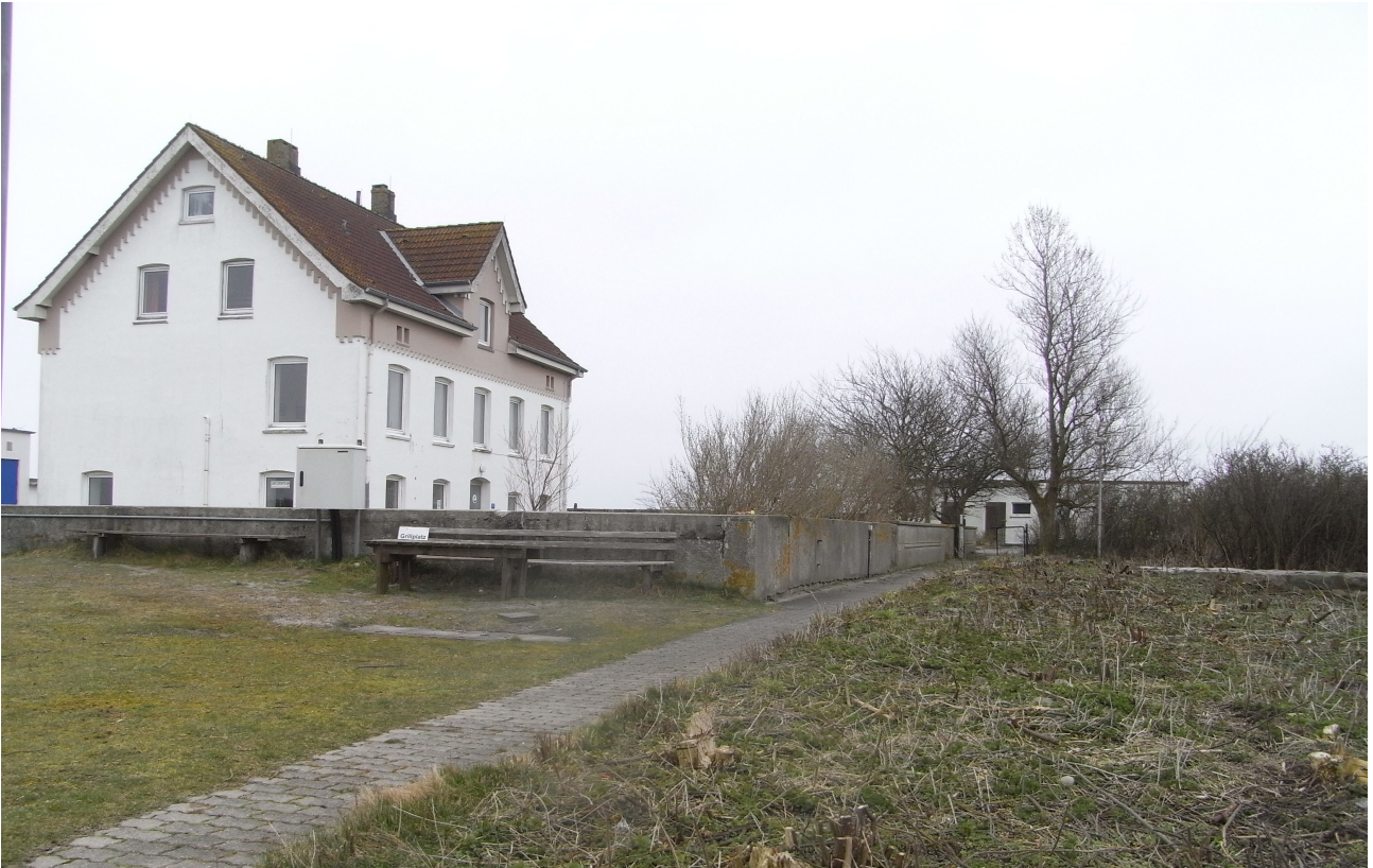
Kuva 3: Päärakennus ja sinne vievä laatoitettu tie, taustalla varistorakennus (maaliskuu 2009)
