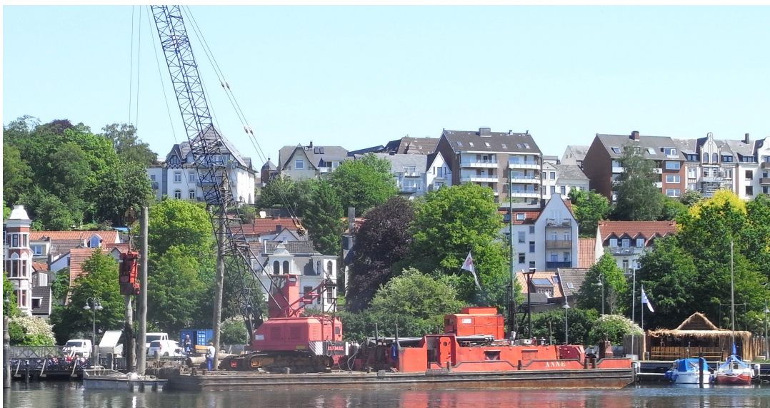
Kuva 6: Puisten paalujen vaihto uusiin Flensburgin kaupungissa (toukokuu 2009)
