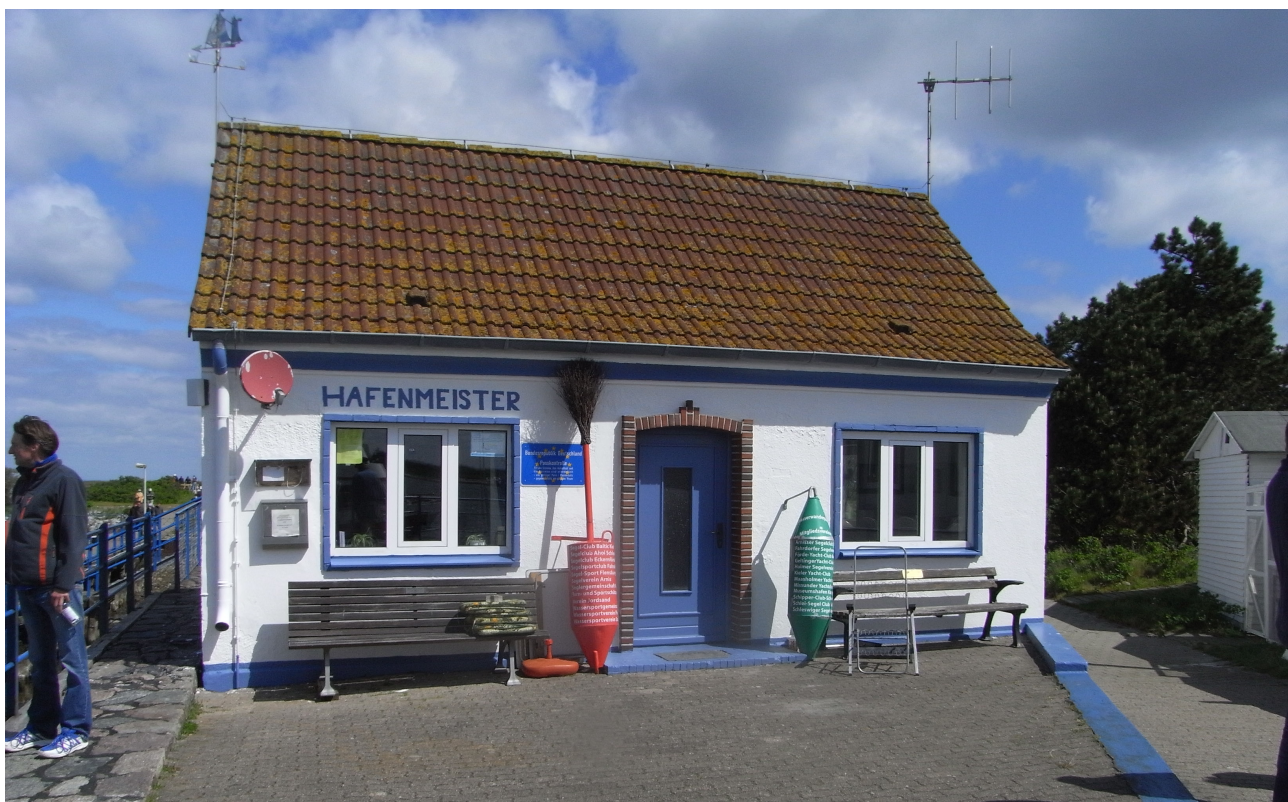
Kuva 2: Satamanpitäjän rakennus (toukokuu 2009)
