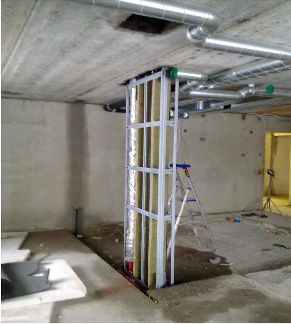
Kuva 6. Silotek-hormi Katajan työmaalla.
