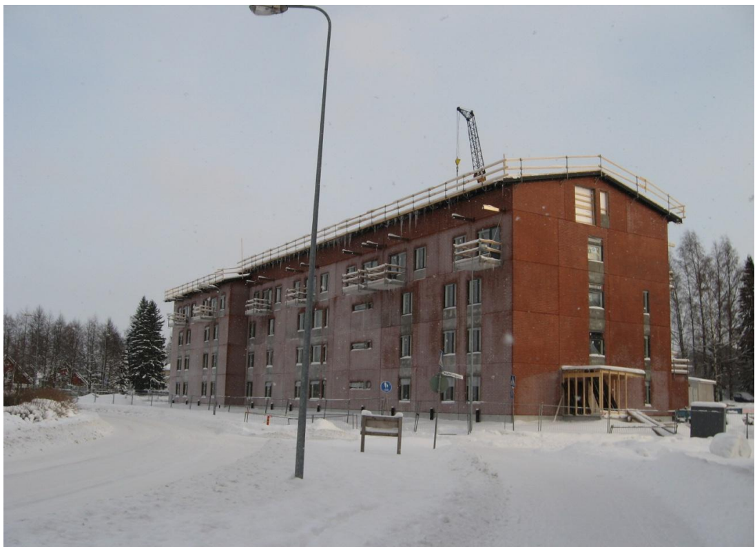
Kuva 1. Kiinteistö Oy Katajan työmaa.
