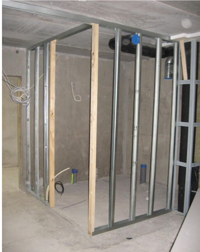
Kuva 4. Väliseinärunkoa Katajan työmaalla.
