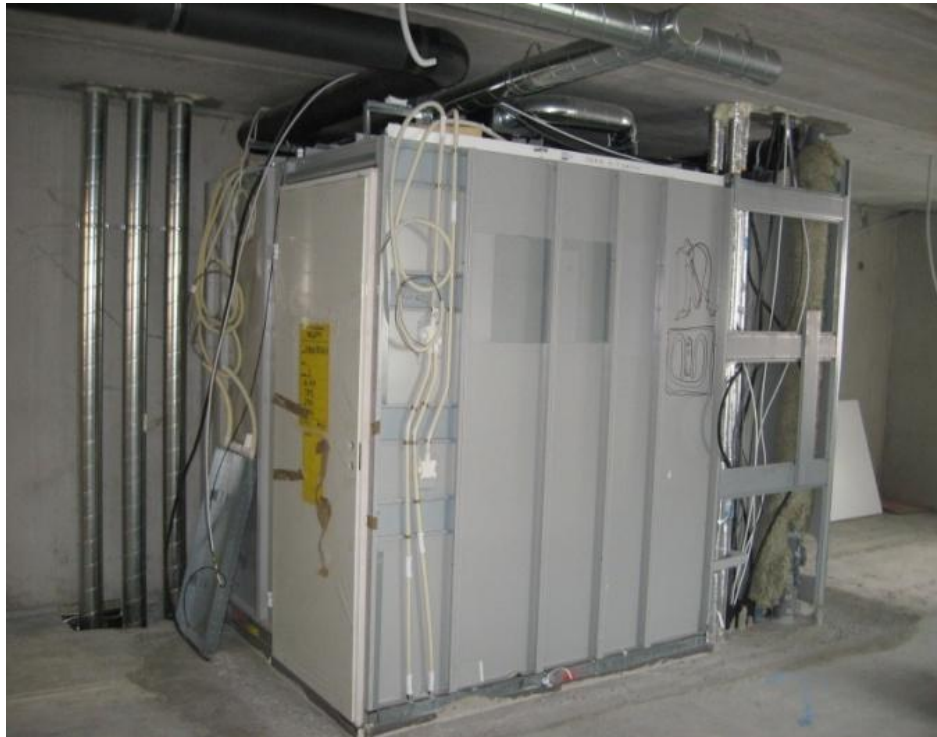
Kuva 7. Märkätilaelementti Oksalan työmaalla.
