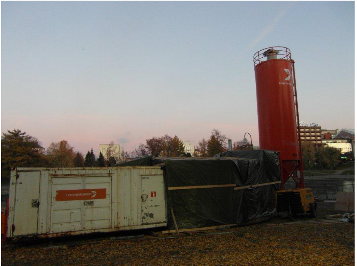
KUVA 4. Katettu suspensioasema. (Lemminkäinen Infra Oy, Frenckellin patotyömaa 2011.)
