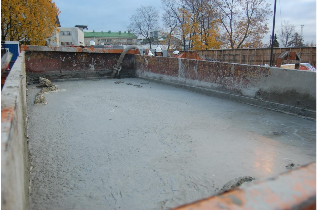
KUVA 7. Suihkuinjektointilietettä lavalla. (Lemminkäinen Infra Oy, Jyväskylän kaupungintalo 2010)
