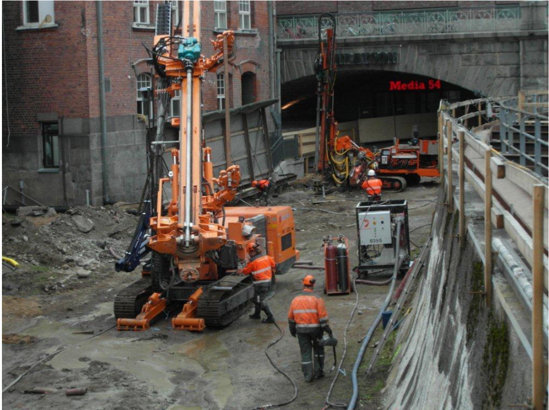
KUVA 5. Porauskalustoa. (Lemminkäinen Infra Oy, Frenckellin patotyömaa 2011.)
